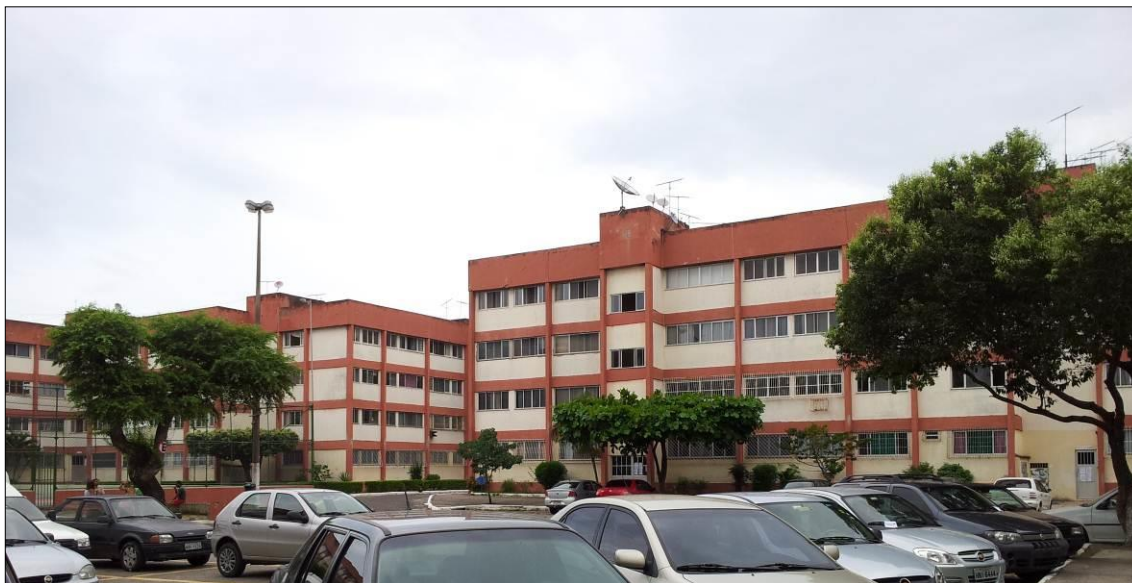
Figura 7 - Prédios do Condomínio Itaparica Mar
