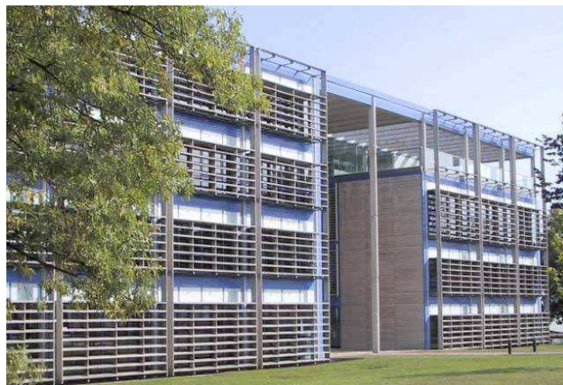
Figura 1 - Detalhe do acesso principal da empresa francesa de energia. Fonte: Alvarenga (2002).
