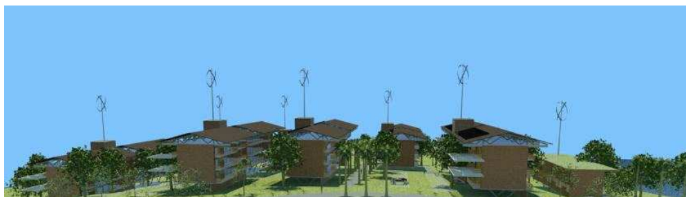
Figura 34 - Imagem geral mostrando todos os edifícios vistos da rua.
