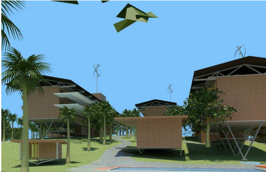
Figura 38 - Imagem mostrando ampliação dos edifícios vistos da lagoa, onde se observa o uso de materiais diversos (aço nas estruturas e pérgolas, concreto nas lajes [stainless steel deck] e madeira nos guarda-corpos, madeiramento no telhado e grelha nos frontões).
