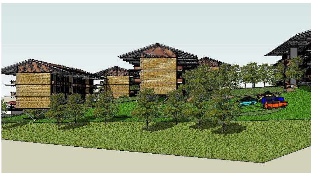
Figura 46 – Vista geral dos edifícios residenciais mostrando os materiais utilizados nas fachadas (blocos de solo cimento, madeira nos frontões e nas varandas e estrutura em aço).
