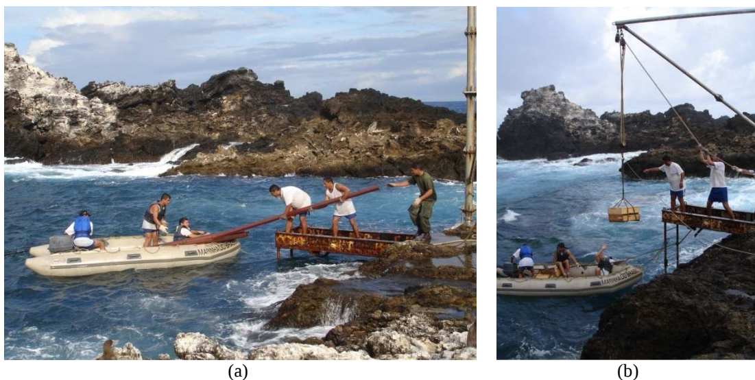
Figura 56: Em (a), transporte de peças de madeira do sistema viga-laje pelo píer da ilha Belmonte; e em (b), içamento de caixas contendo os discos em concreto das fundações com o auxílio do equipamento de força denominado “turco”. Observa-se nas imagens a variação do nível da maré. Fonte: acervo LPP/UFES (2007).
