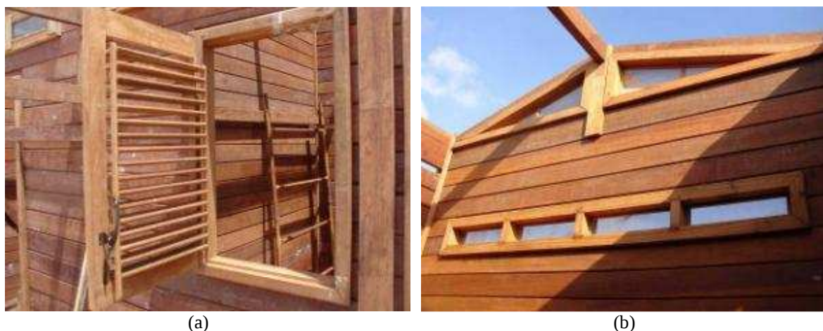
Figura 38: Em (a), janela venezianada de um dos ambientes com aletas na posição aberta; e em (b), aberturas de ventilação superiores. Abaixo da peça de cumeeira, observam-se as aberturas dos oitões, que fazem a ventilação do ático. Na imagem em questão, ainda não havia sido instalado o forro.
