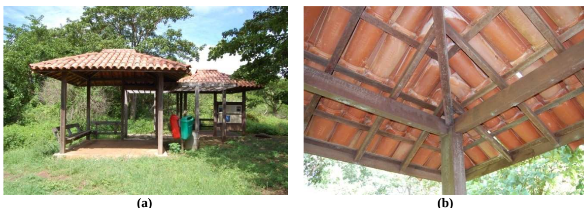
Figura 25: Em (a), vista geral do PIC Descanso Duplo do Mirante dos Golfinhos; e em (b), vista inferior do madeiramento do telhado da mesma edificação.
