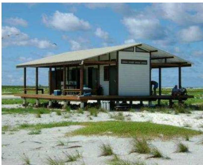
Figura 40: Vista da segunda Estação Científica do Atol das Rocas após pintura.
