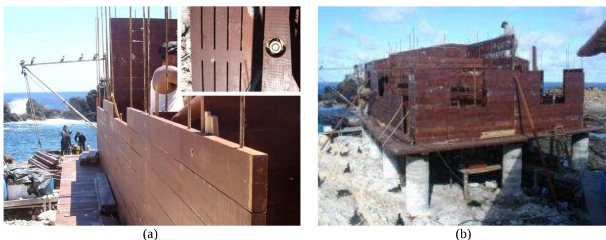
Figura 59: Em (a), encaixe das vigotas das paredes nas barras rosqueadas. Observar detalhe do encaixe do parafuso, em vista de topo; e em (b), aspecto geral da montagem das paredes. Fonte: acervo LPP/UFES (2007).
