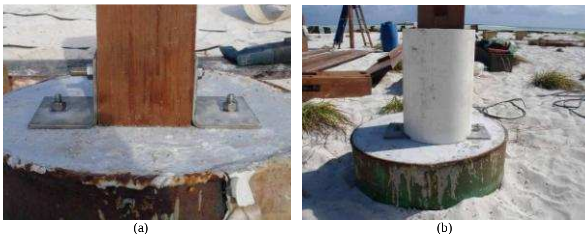
Figura 35: Em (a) fixação do pilarete da base com cantoneiras de aço inox; e em (b), tubo de PVC revestindo o pilarete.
