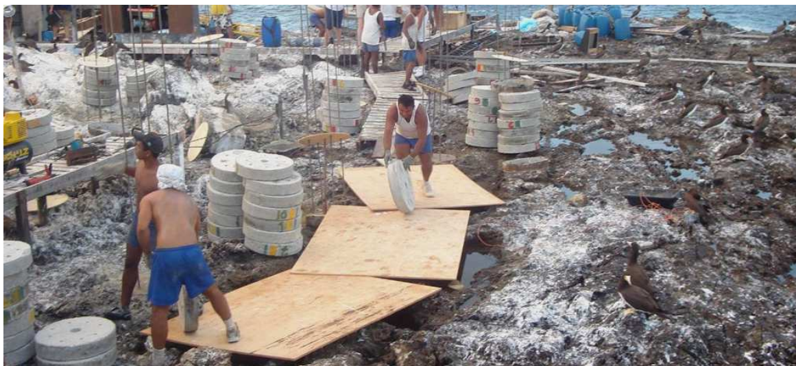
Figura 53: Transporte por rolamento dos discos de concreto sobre chapas de compensado. Fonte: GUMZ (2008, p. 93).
