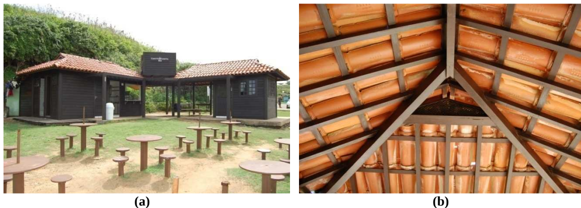
Figura 24: Em (a), vista geral do PIC Completo da Praia do Sueste; e em (b), vista de parte do madeiramento do telhado da mesma edificação.
