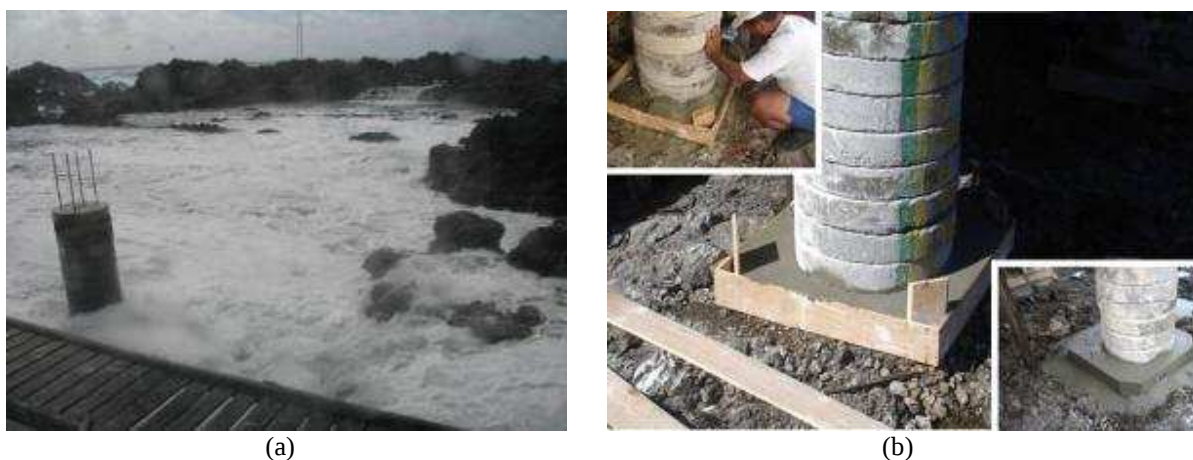
Figura 54: Em (a), pilarete sofrendo ação das ondas. Observa-se a fixação dos seus discos de concreto em quatro barras de aço; e em (b), concretagem das cintas de proteção. Fonte: GUMZ (2008, p. 100-103).
