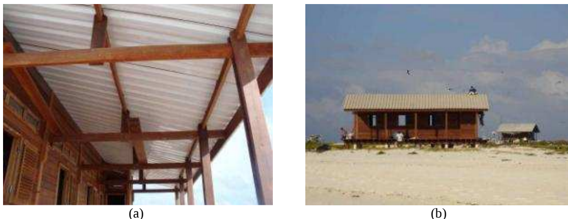
Figura 39: Em (a) vista interna da cobertura a partir de uma das varandas, e em (b), aspecto geral externo da cobertura com a edificação ainda sem pintura. Em segundo plano, observa-se a primeira Estação construída no Atol das Rocas.
