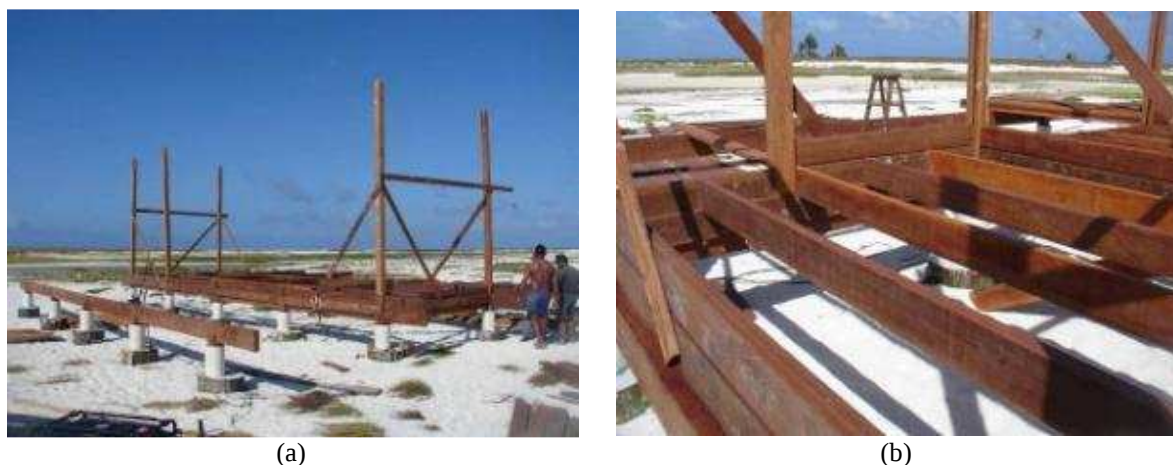
Figura 36: Em (a), vigamento do piso. Em primeiro plano, as vigas simples do deck e em segundo plano, já suportando alguns montantes das paredes, as vigas compostas; e em (b), fixação dos barrotes do piso sobre as vigas compostas.
