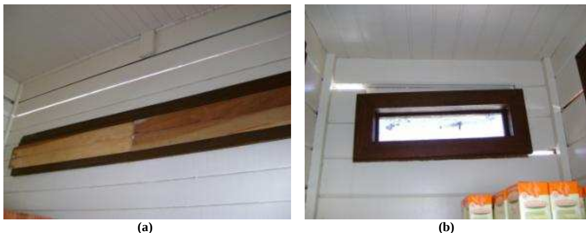
Figura 45: Em (a), vista da janela do ambiente projetado para banheiro seco com frestas laterais entre as peças de vedação da parede; e em (b), fechamento de uma abertura de ventilação superior do dormitório da chefia da UC, fachada Sul, como medida temporária para conter a entrada de água da chuva. Observa-se acima da janela uma fenda provocada por variação dimensional das peças de madeira.
