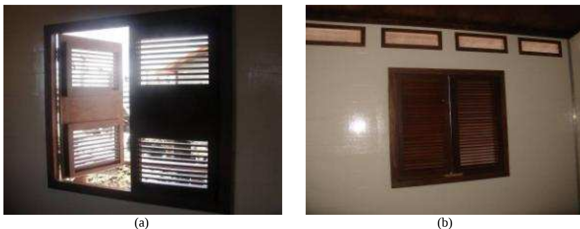
Figura 62: Em (a) janela do alojamento com aletas das venezianas na posição aberta; e em (b), janela da sala de estar com aletas fechadas. Sobre a janela, observam-se as aberturas de ventilação já com a tela metálica de proteção instalada. Fonte: acervo LPP/UFES (2007).
