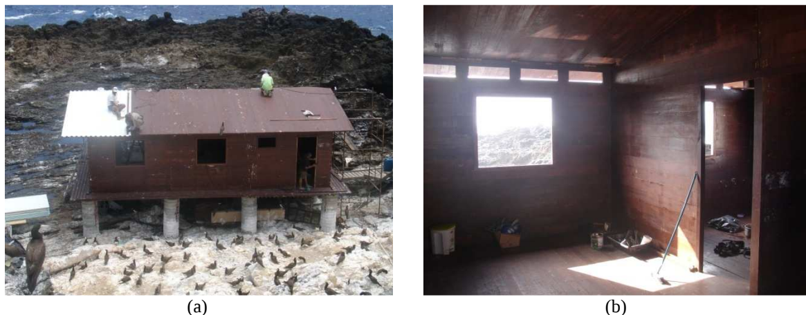
Figura 61: Em (a), fixação das telhas de alumínio sobre a cobertura de vigotas; e em (b), aberturas superiores de ventilação acima da janela da sala de estar. Fonte: acervo LPP/UFES (2007).
