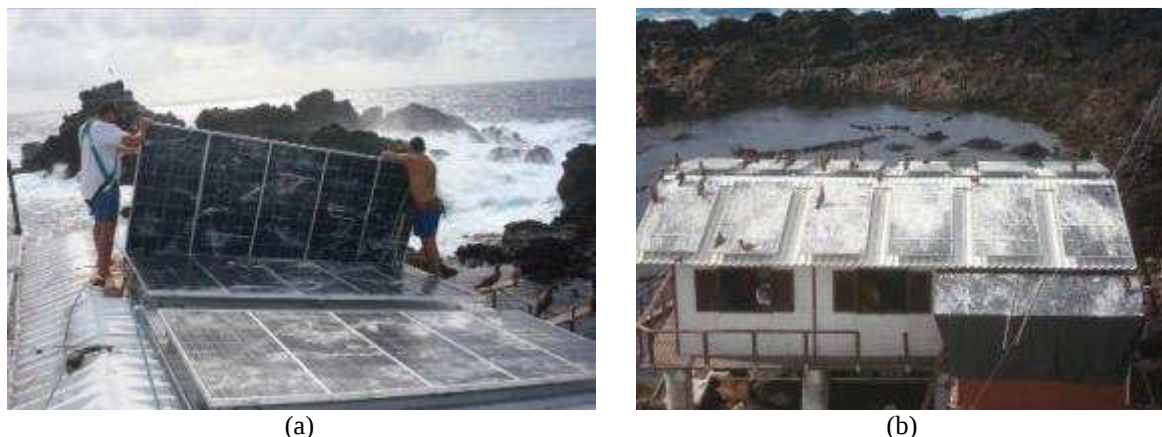
Figura 66: Em (a), instalação dos painéis solares do sistema fotovoltaico; e em (b), vista geral da finalização da instalação dos painéis. Observa-se o cobrimento quase total das placas pelo guano das aves, o que gera a necessidade de limpeza constante. Fonte: Marco Antônio Carvalho de Souza (2008).
