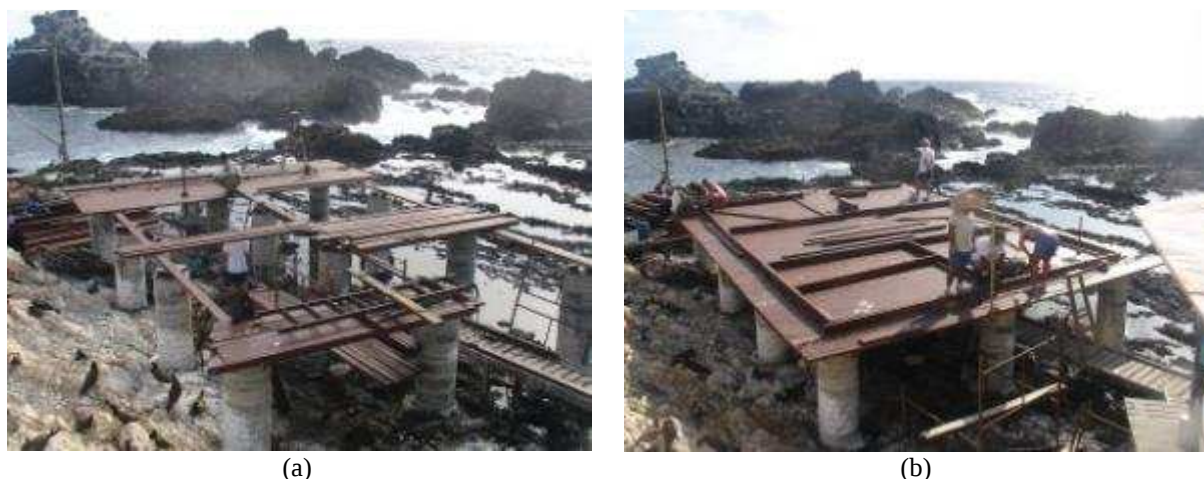
Figura 58: Em (a), montagem do piso; e em (b), finalização da montagem do piso e início da fixação das vigotas das paredes. Fonte: acervo LPP/UFES (2007).
