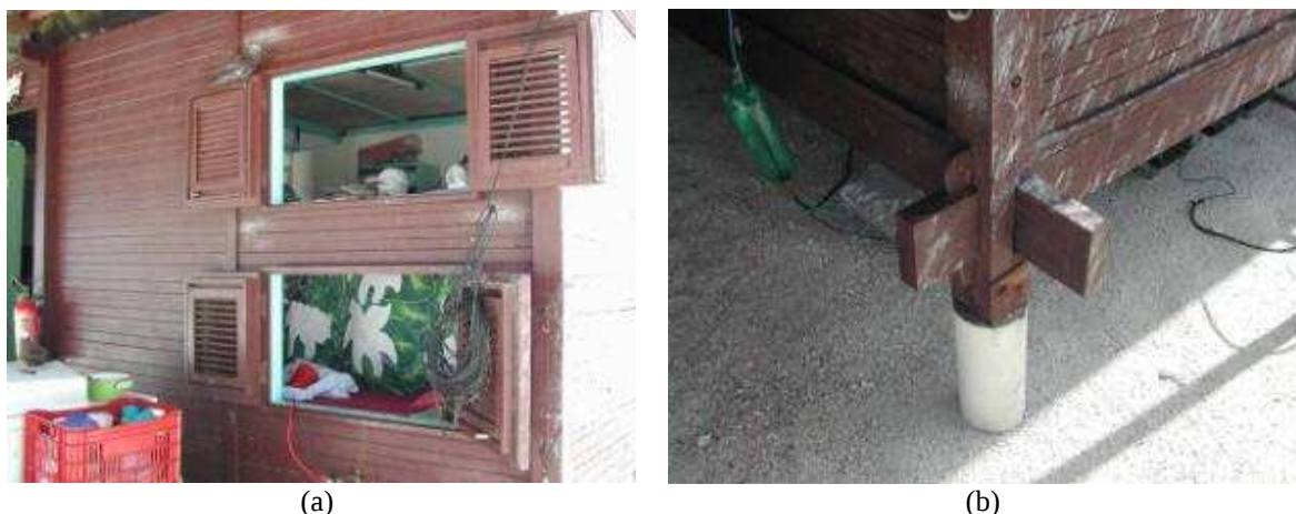
Figura 32: Em (a), janelas venezianadas adotadas para o Atol, modelo tradicional na região Nordeste do Brasil; e em (b), vista de um dos pilaretes revestidos com tubo de PVC para impedir o acesso de roedores à edificação.
