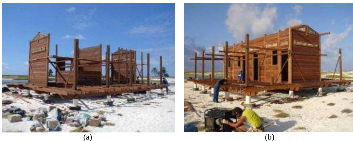
Figura 37: Em (a), montagem dos oitões e paredes internas; e em (b), finalização da montagem das paredes.
