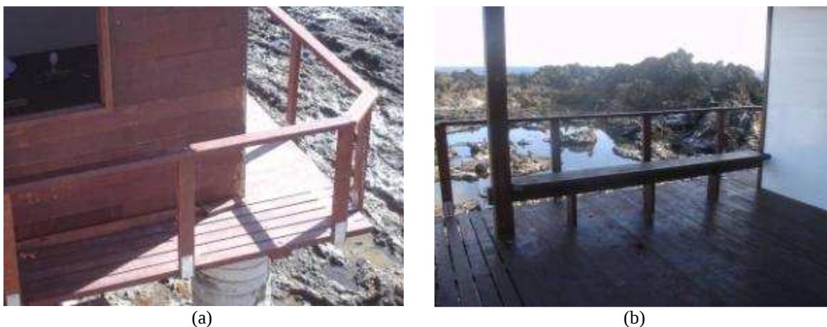
Figura 63: Em (a), guarda-corpo das passagens laterais dos decks . A fixação dos componentes estruturais foi feita com cantoneiras parafusadas no piso; e em (b), banco da varanda, tendo o guarda-corpo ao fundo. Fonte: acervo LPP/UFES (2007).
