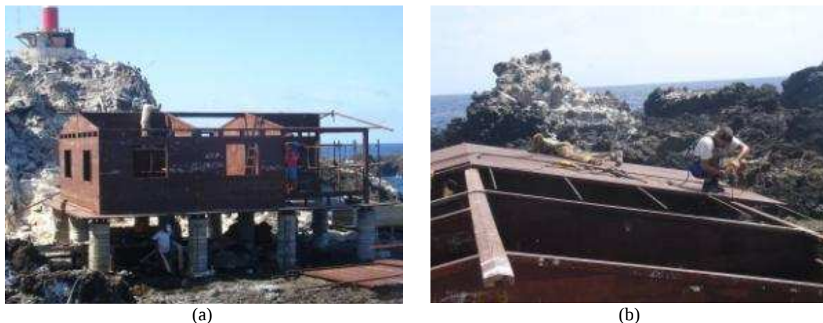
Figura 60: Em (a), fixação das peças-guia da cobertura sobre os painéis das paredes; e em (b), início da montagem da cobertura. Fonte: acervo LPP/UFES (2007).
