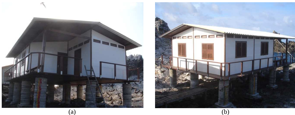
Figura 64: Em (a) e (b): vistas da nova Estação após a conclusão dos trabalhos. Fonte: Acervo LPP/UFES (2007).
