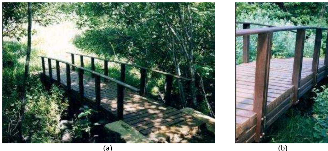
Figura 13: Em (a) modelo de ponte desenvolvido para o PARNAMAR-FN, localizado na trilha Sancho-Mirante dos Golfinhos; e em (b), detalhe da estrutura e guarda-corpo. Fonte: ALVAREZ (2001b, p.14).
