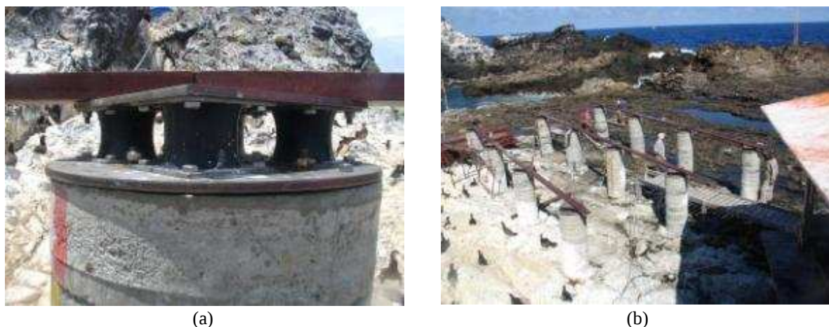
Figura 57: Em (a) fixação das vigas de apoio do piso no conjunto de amortecedores; e em (b), visão geral das fundações da nova Estação com os amortecedores e com as vigas de apoio do piso. Fonte: acervo LPP/UFES (2007).
