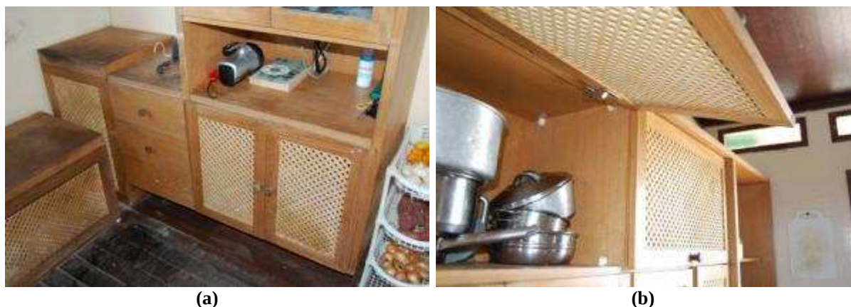
Figura 72: Em (a), armário projetado para abrigar os equipamentos do sistema de comunicação. Apesar de apresentar aspecto envelhecido, está em excelente estado de conservação; e em (b), armário alto da cozinha também em excelentes condições. Observa-se que o uso de portas treliçadas objetiva reduzir o acúmulo de umidade no interior dos armários.
