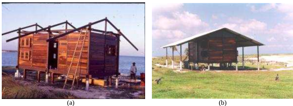
(a) (b) Figura 30: Em (a), vista da primeira Estação Científica do Atol das Rocas durante a sua construção; e em (b), aspecto da Primeira Estação após finalização da obra. Fonte das imagens: Cristina Engel de Alvarez.
