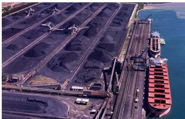
Figura 30 - Pátios de estocagem com slots privados e porto de embarque.
