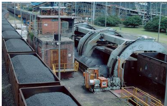
Figura 29 - Composição ferroviária com viradores de vagão ( car-dumpers ).
