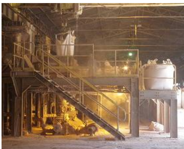
Figura 27 - Processos de descarga e bombeamento de bentonita no cliente.
