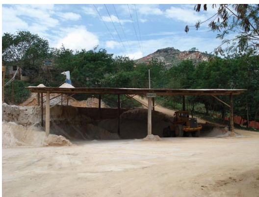
Figura 19 - Área de armazenagem coberta no fornecedor de calcário.
