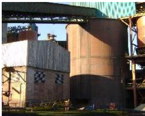
Figura 23 - Silo de calcário bruto no cliente.
