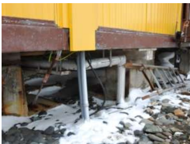
Figura 26. Base da Estação com perfis metálicos.
