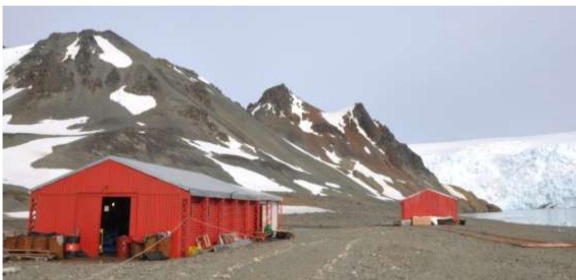
Figura 31. Edifício garagem/gerador (esquerda) e módulo de emergência (direita).
