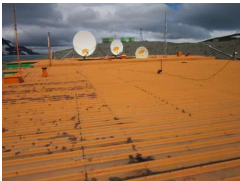
Figura 13. Cobertura da EACF em fevereiro de 2011.
