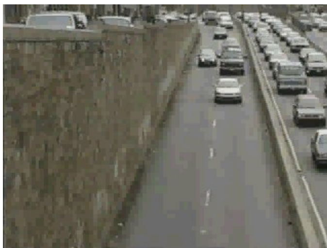
Figura 5: Efeito da largura insuficiente Fonte: HCM (2000)
