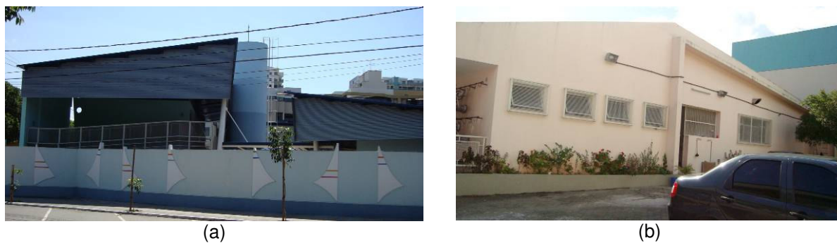
Figura 14: Vistas das paredes de alvenaria do CMEI 1 (a) e do CMEI 2 (b)
