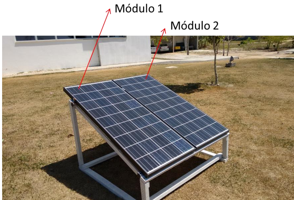
Figura 29 - Testes em módulos fotovoltaicos sem sombreamento
