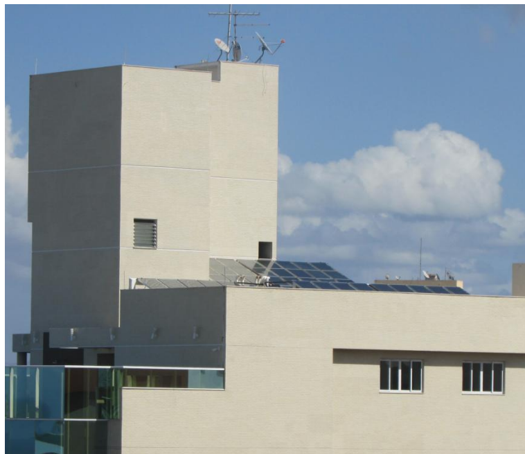
Figura 3 - Exemplo de uma unidade de Microgeração Fotovoltaica
