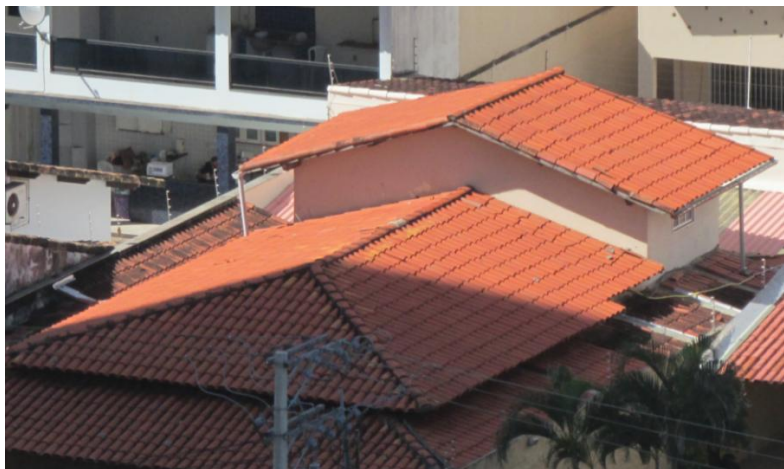
Figura 4 - Telhado de uma residência com sombreamento provocado por edifício vizinho
