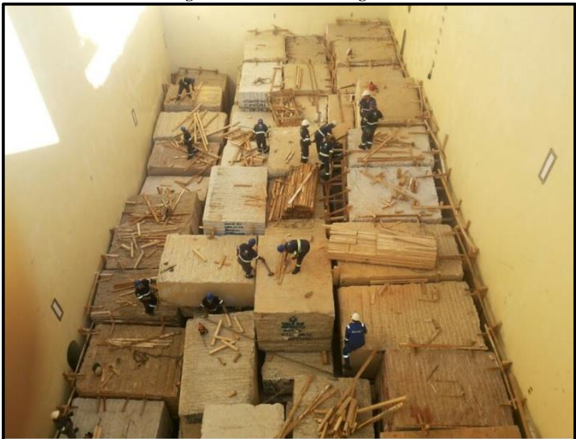
Figura 4 – Escoramento de granito
