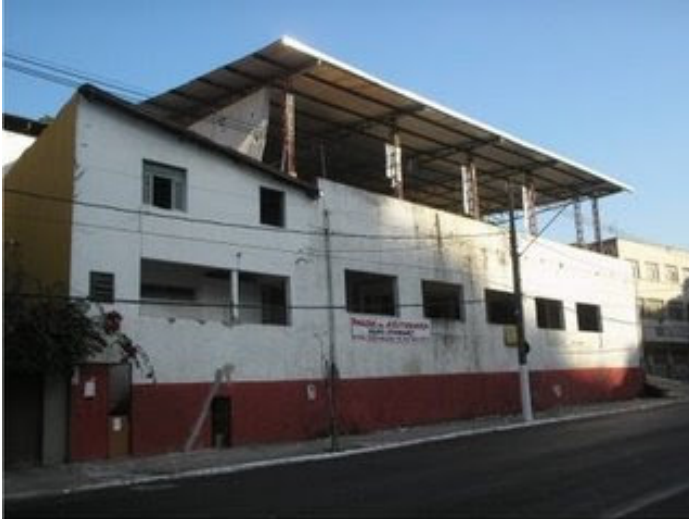
Figura 3 – Estrutura externa da quadra Fonte: http://amomuitofradinhos.blogspot.com.br/
