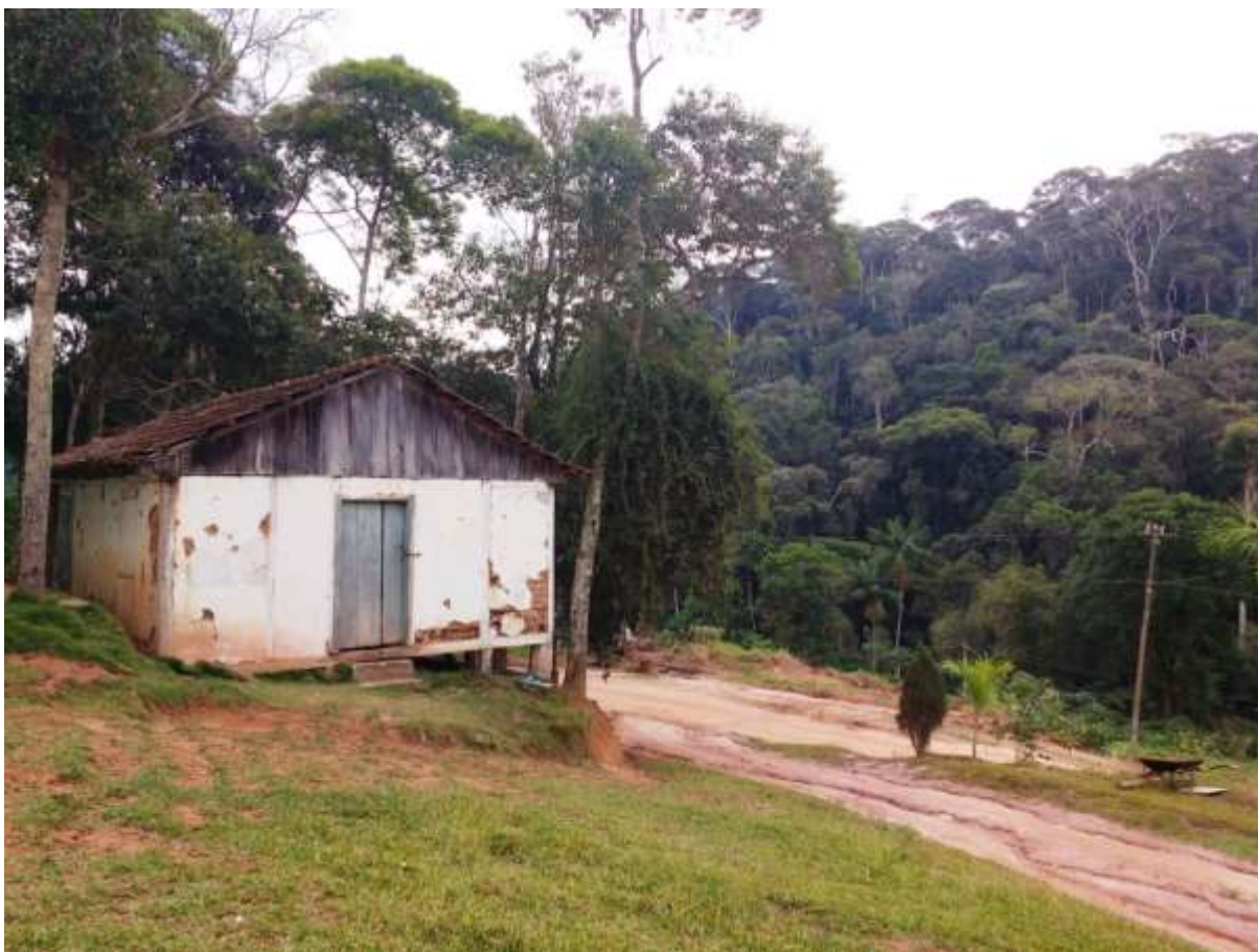
Figura 18 - Primeira sala de aula construída pela comunidade para as séries finais do Ensino Fundamental em Alternância.
