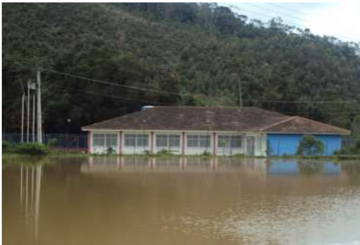
Figura 8 - Vista parcial do prédio onde funcionam as séries iniciais da EEEFM. Emílio Schroeder
