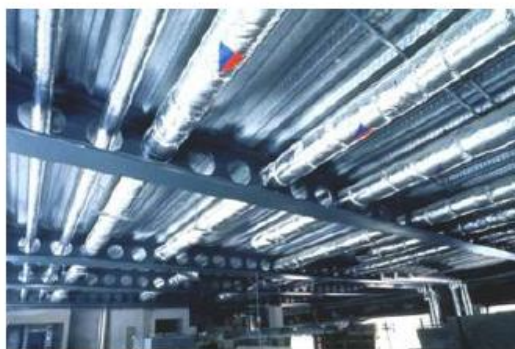
Viga mista – perfil de alma cheia e laje mista
