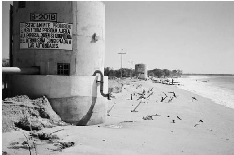
Figura 2.8 - Poço radial em Salina Cruz, México (Voutchkov, 2013).
