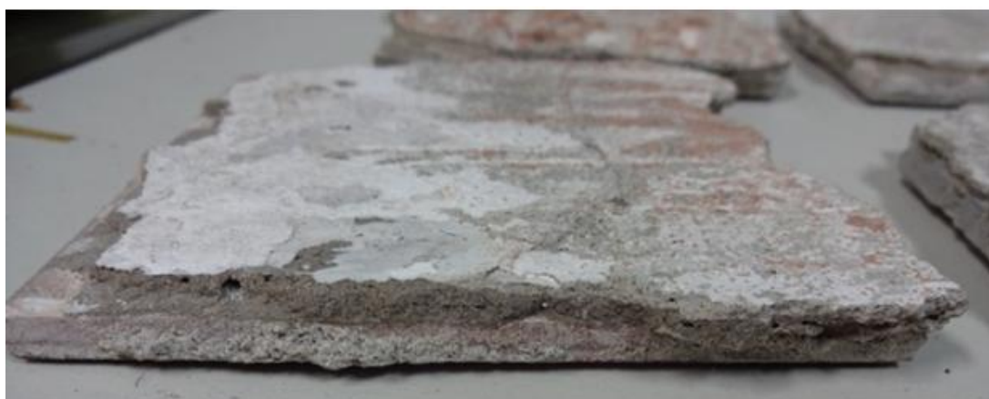
Figura 5.96 – Argamassa bem aderida à cerâmica com resquícios de pintura
