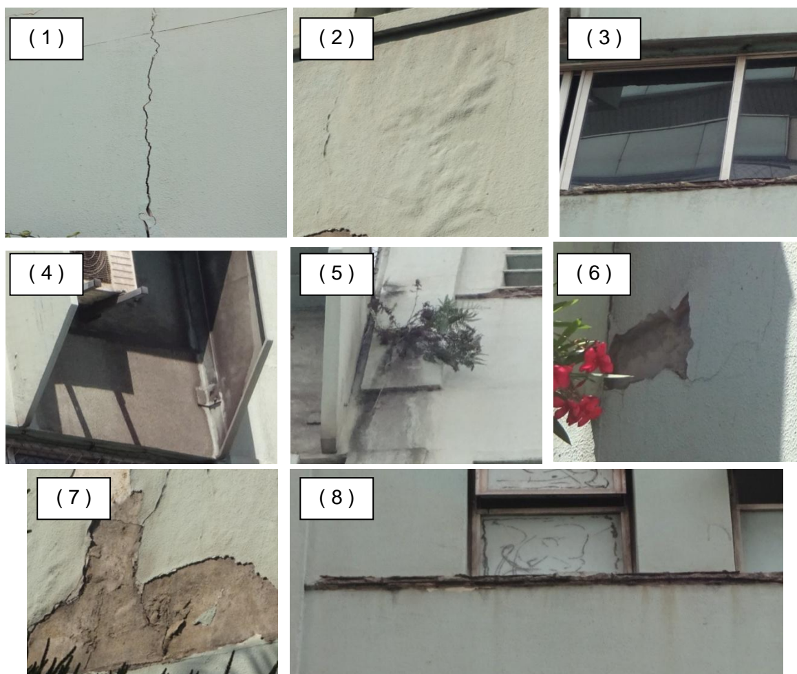
Figura 5.53 – Manifestações patológicas constatadas em ARG3
