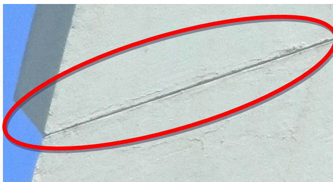
Figura 5.72 – Fissura na junta de ARG3
