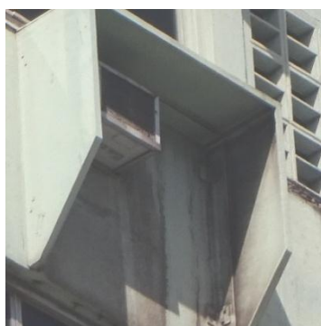
Figura 4.10 – Proteção das caixas de ar condicionado
