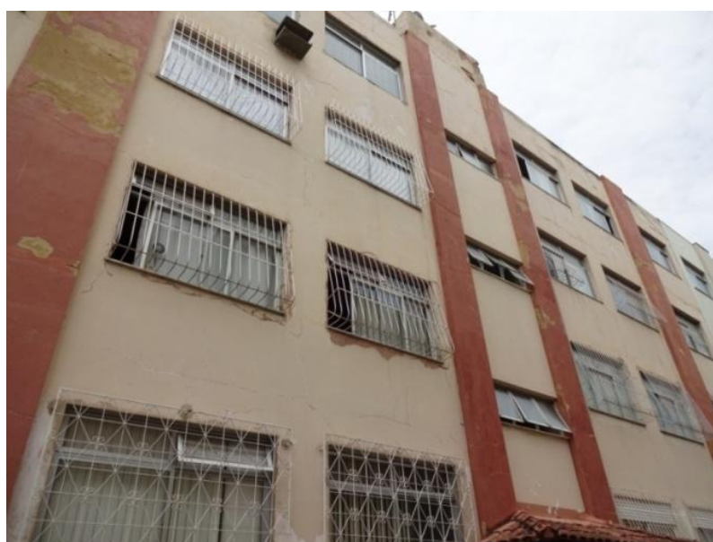
Figura 4.5 - Edifício ARG2 - Fachada frontal
