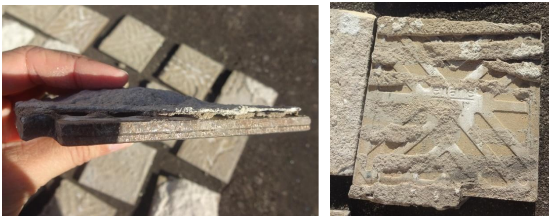
Figura 5.154 – Cordões de argamassa visíveis nas cerâmicas de CER3
