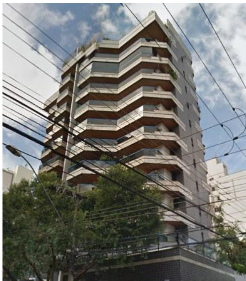
Figura 4.19 - Edifício CER3 - Fachada frontal
