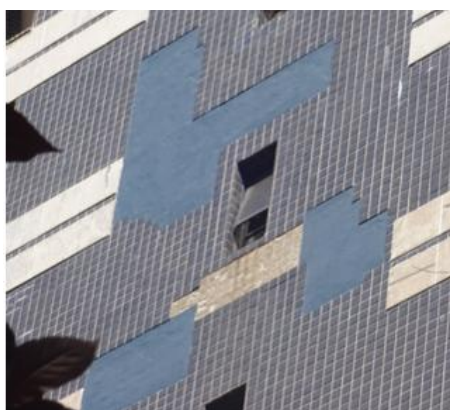
Figura 4.21 – Revestimento cerâmico substituído por pintura
