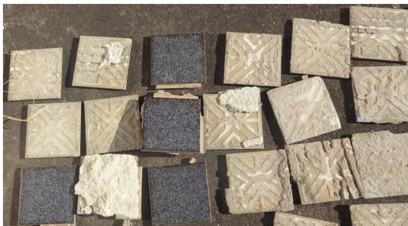
Figura 5.152 – Cerâmicas retiradas da fachada de CER3
