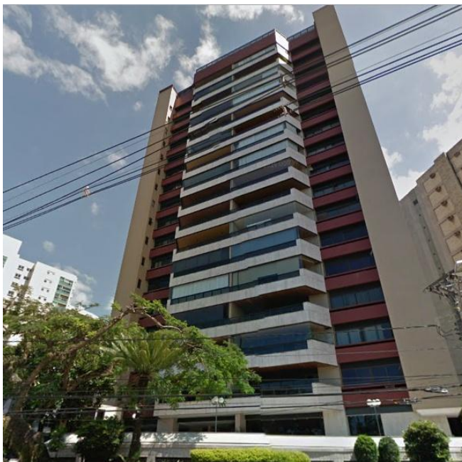
Figura 4.16 - Edifício CER1 - Fachada frontal
