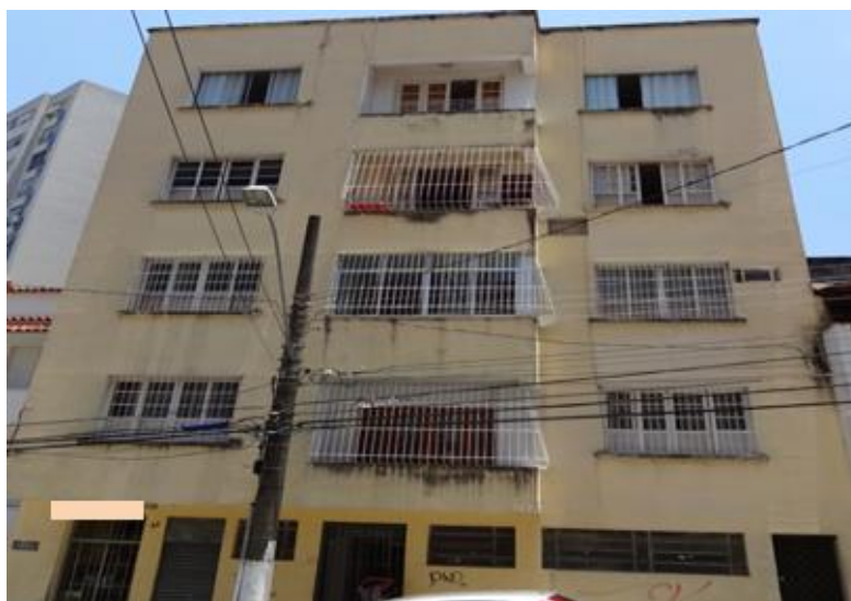
Figura 4.2 - Edifício ARG1 - Fachada frontal
