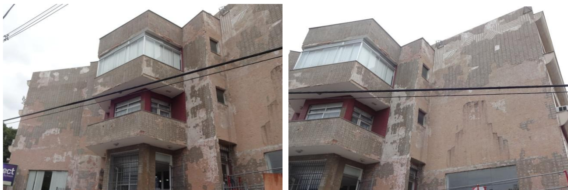
Figura 5.98 – Início da reforma da fachada frontal de CER1
