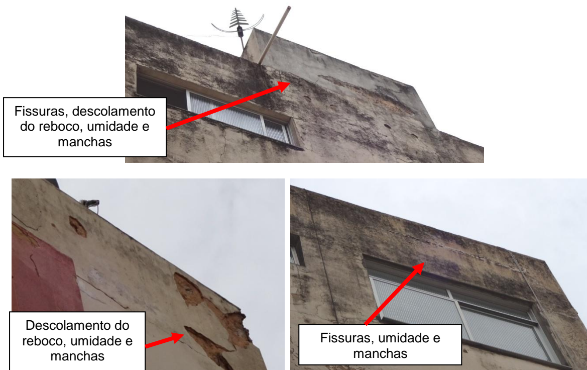
Figura 5.44 – Região do topo nas fachadas de ARG2
