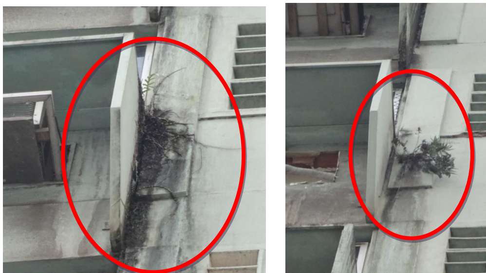
Figura 5.71 – Umidade e vegetação em ARG3
