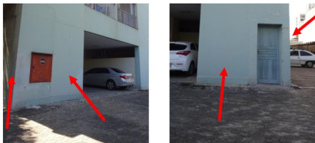
Figura 4.11 – Modificações realizadas no térreo de ARG3
