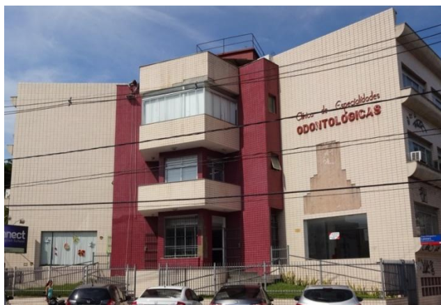
Figura 4.12 - Edifício CER1 - Fachada frontal
