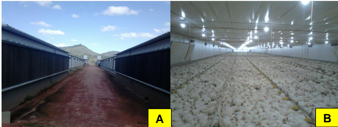
Figura 4 - Imagens coletadas durante a realização dos experimentos: (a) – vista do exterior de um galpão escuro tipo, mostrando a disposição das placas evaporativas; (b) – vista do interior de um galpão escuro.
