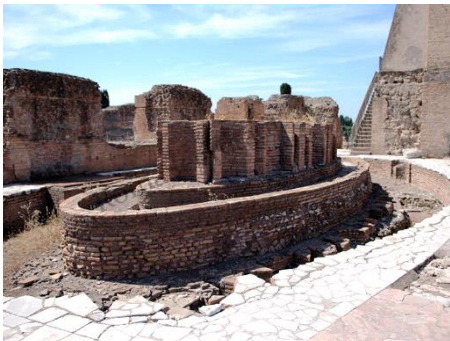
Figura 65 — Parte sudoeste da Domus Flávia, vista do Leste, em seu estado atual de preservação
