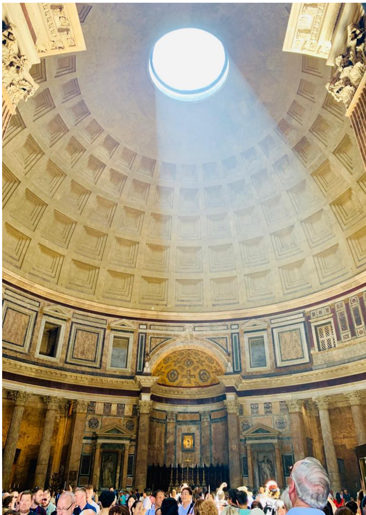
Figura 66 — O interior da rotunda do Panteão, em Roma, com ênfase para os lacunaria
