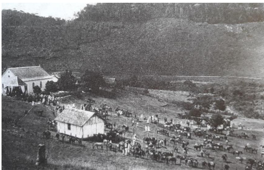
Figura 20 - Primeira igreja e a escola capela do vilarejo do distrito de Jetibá
