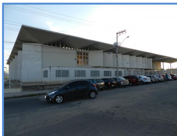
Fotografia 4: Vista da entrada da escola
