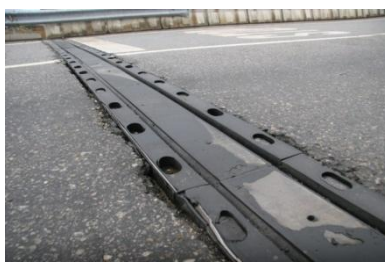
Figura 1.1-b: Mostra outro tipo de junta de dilatação existente entre a junção de duas vigas
