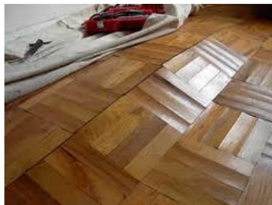
Figura 1.5: Mostram, respectivamente, alguns pisos trincados e estufados.
