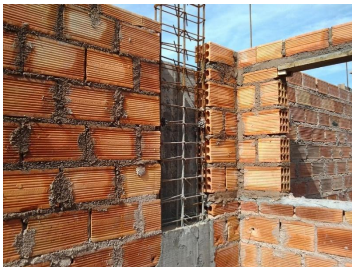
Figura 2.2: Junção dos vergalhões de ferro com concreto.
