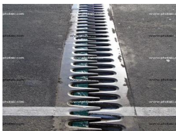
Figura 1.1-a: Mostra um tipo de junta de dilatação existente entre a junção de duas vigas
