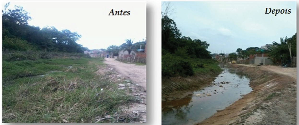
Figura 10 – Limpeza da lagoa
