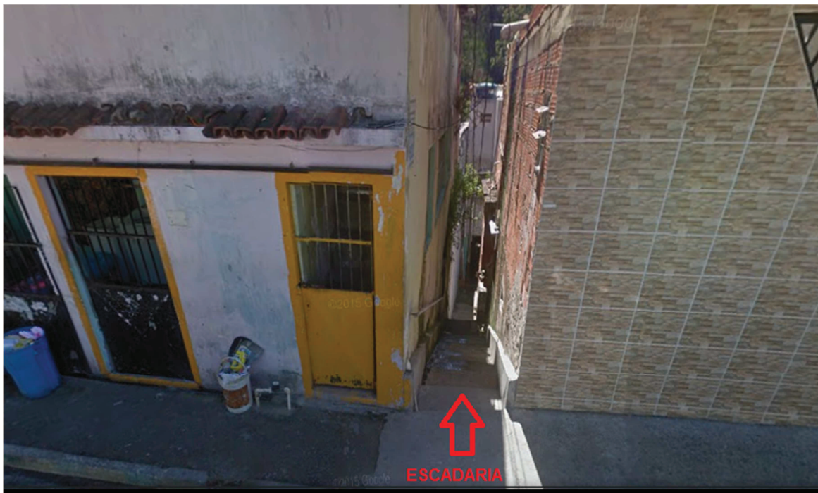
Figura 5 – Escadaria de acesso a casas
