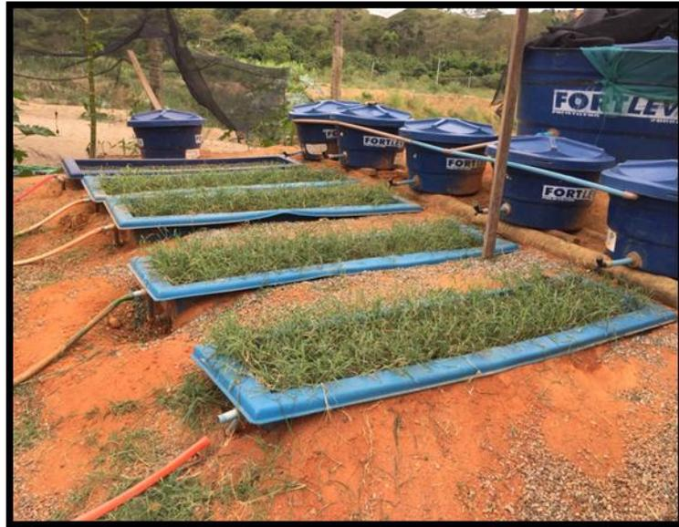
**Figura 2** - Vista lateral do sistema de tratamento, constituído por cinco SAC's, sendo quatro vegetados e um sem vegetação.
