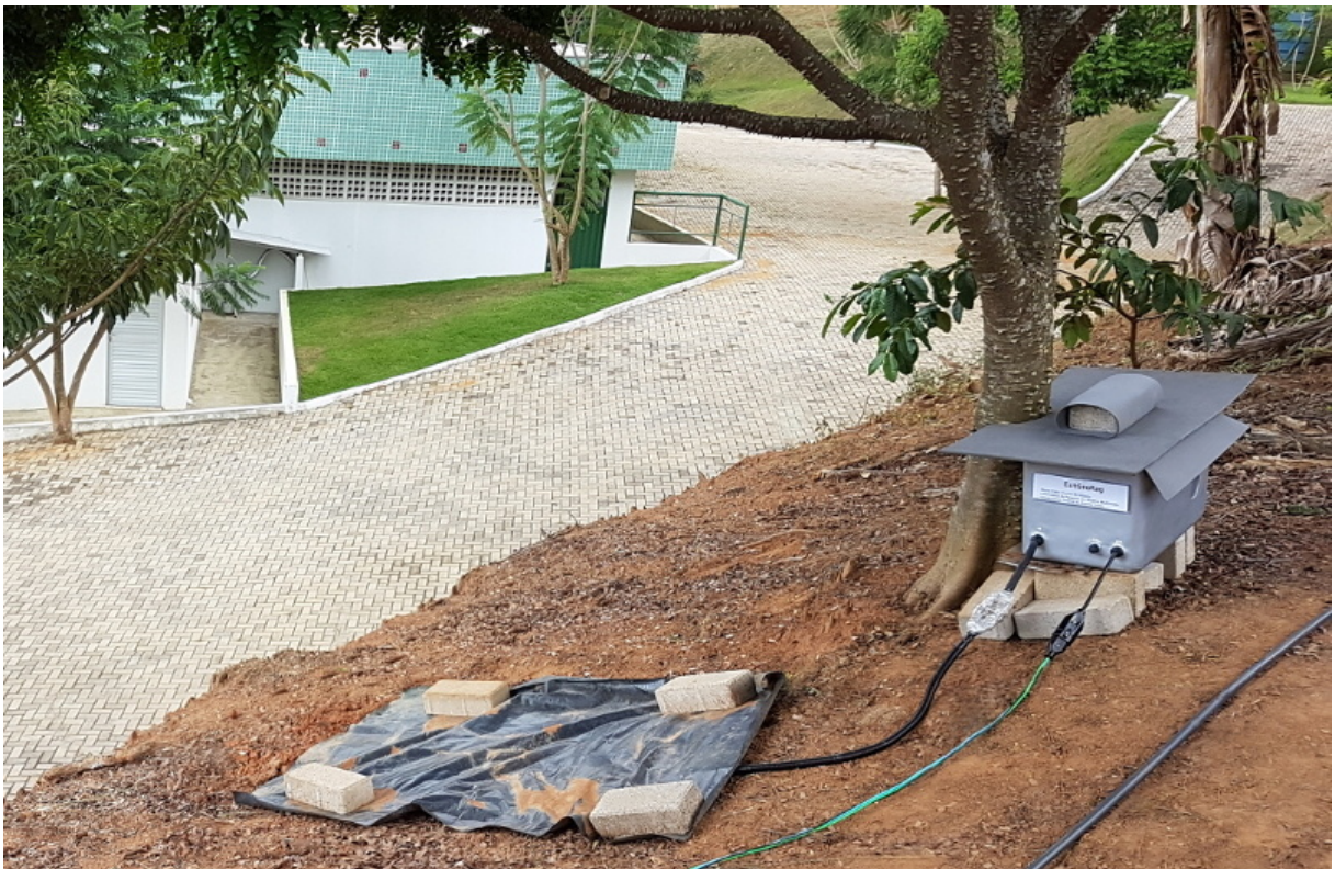
Figura 6.18: Instalação da EstGeoMag concluída
