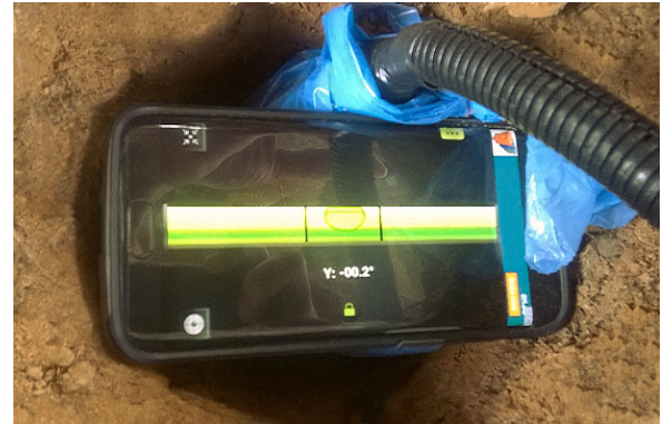
(6.17.2) Nivelamento vertical feito com auxílio de um smartphone
