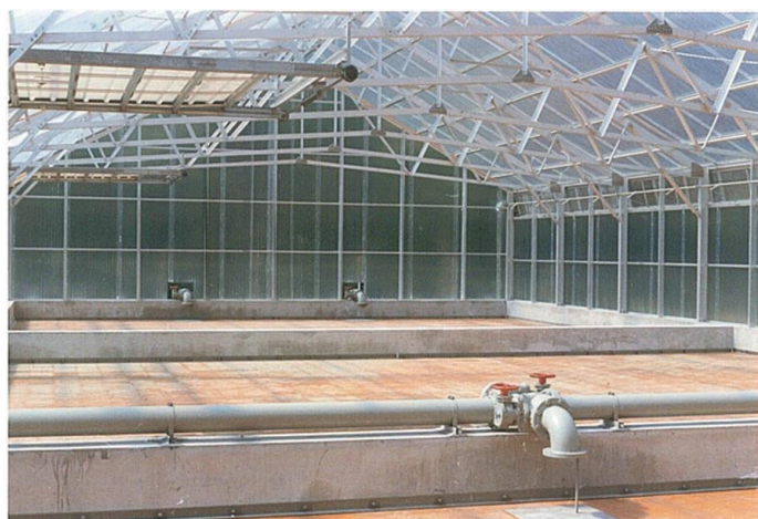
Figura 8 – Leito de secagem por blocos drenantes coberto Fonte: Gravity Flow Systems Southwest, Inc.
