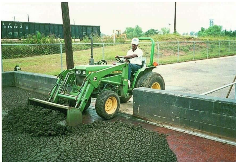
Figura 9 – Método de limpeza do leito de secagem na cidade de Bay Minette, Alabama (EUA).
