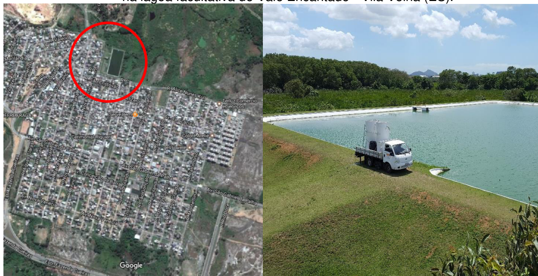
Figura 13: Localização da ETE Vale Encantado. Figura 14: Sistema Polilag em operação na lagoa facultativa de Vale Encantado - Vila Velha (ES).
