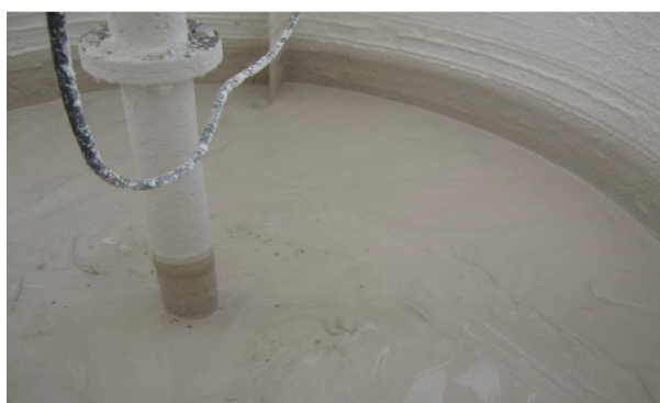
Figura 74. Resíduo proveniente do silo de decantação depositado no tanque agitador, para evitar ressecamento da lama
