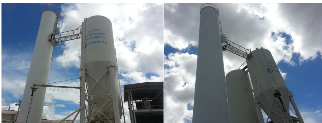
Figura 73. Filtro de decantação de resíduos e o transbordo de água limpa
