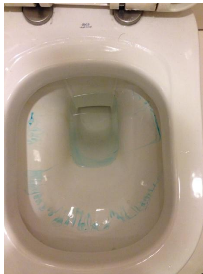
Figura 31 – Vazamento na bacia sanitária
