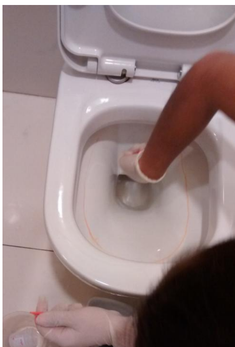
Figura 19 – Teste de vazamento em bacias sanitárias
