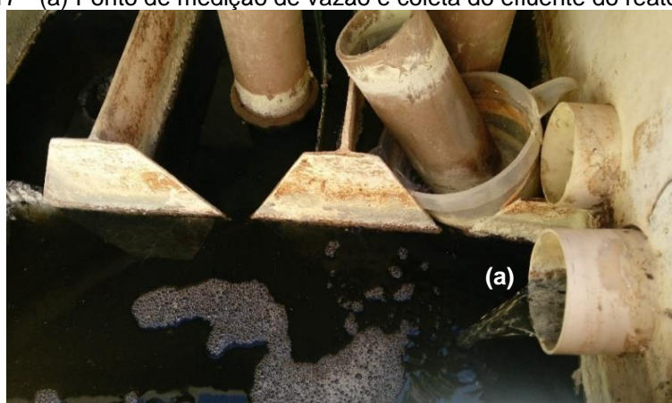
Figura 17 - (a) Ponto de medição de vazão e coleta do efluente do reator UASB .
