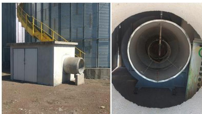
Figura 12: Sistema de insuflação de ar fixo para cada silo (ventilador e queimador)
