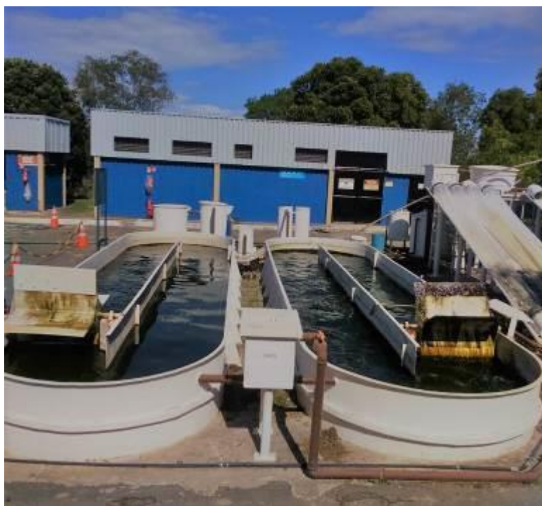
Figura 7 - Lagoas de alta taxa em sistema piloto
