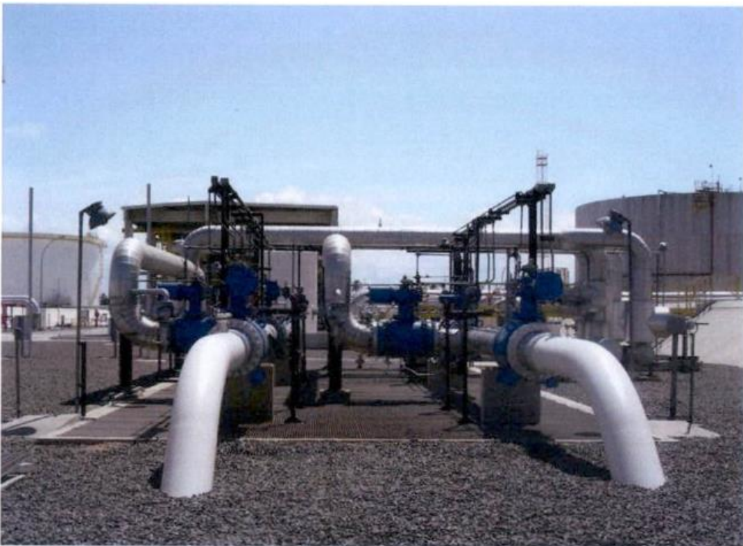
Figura 6 – Scraper de saída e início do oleoduto submarino
