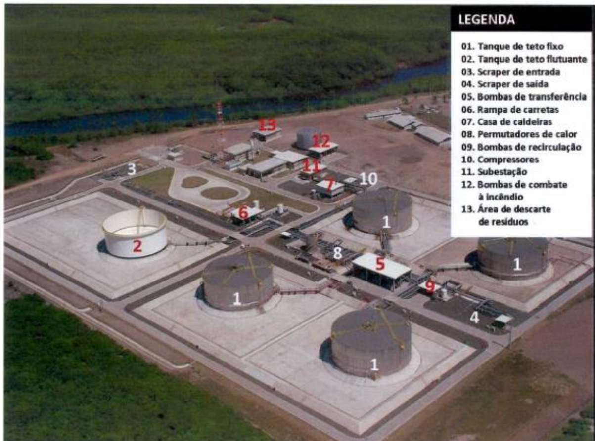
Figura 3 – Área dos tanques de armazenagem de óleo TNC
