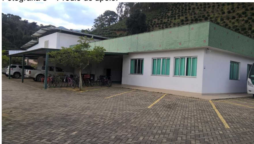
Fotografia 8 – Prédio do apoio.
