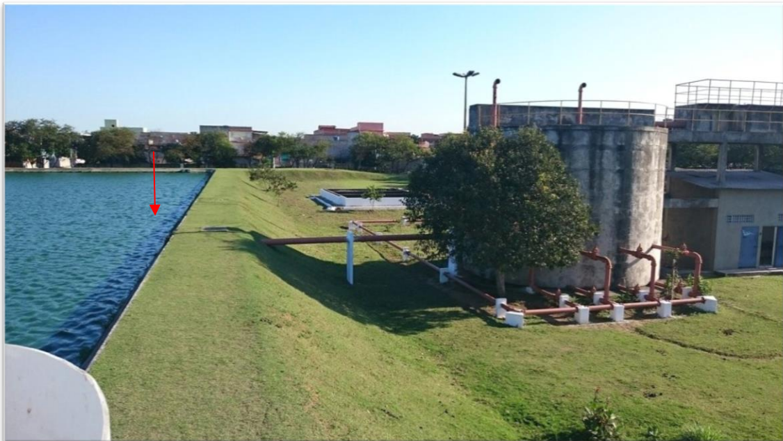
Figura 10: Sistema de tratamento de esgoto UASB + lagoa de estabilização localizado na ETE Vale Encantado, com a saída do efluente do reator indicado pela seta.
