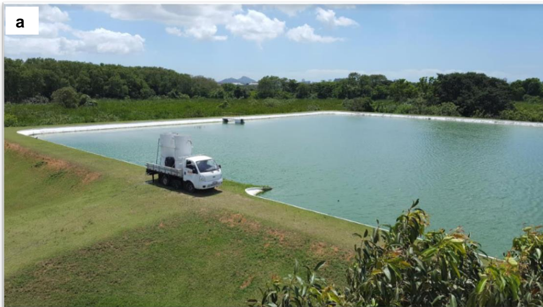
Figura 8- (a) Vista in loco do ponto de coleta. (b) Vista superior da ETE Vale Encantado produzido pelo Google Earth®. (1) Caixa de areia; (2) Reator UASB; (3) Saída efluente UASB; (4) Ponto de coleta Polilag; (5) Lagoa de estabilização; (6) Desaguador de lodo.
