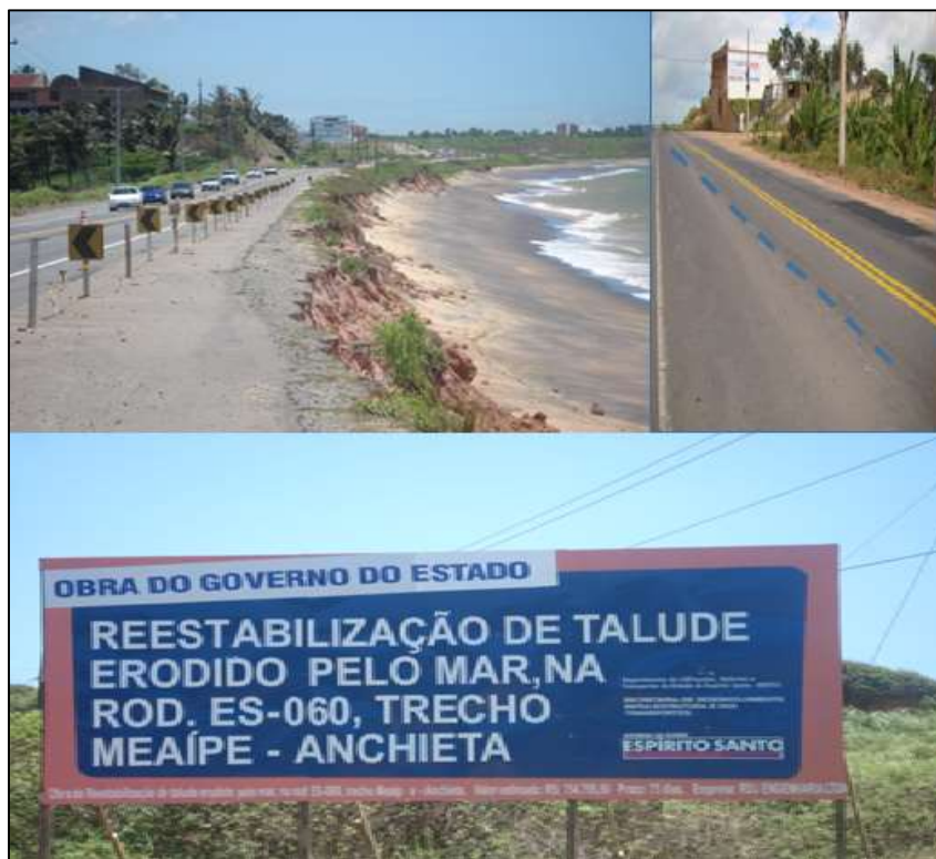
Figura 1. 2 - Processos erosivos constatados na área de estudo. Fotos: Jacqueline Albino em 2008.
