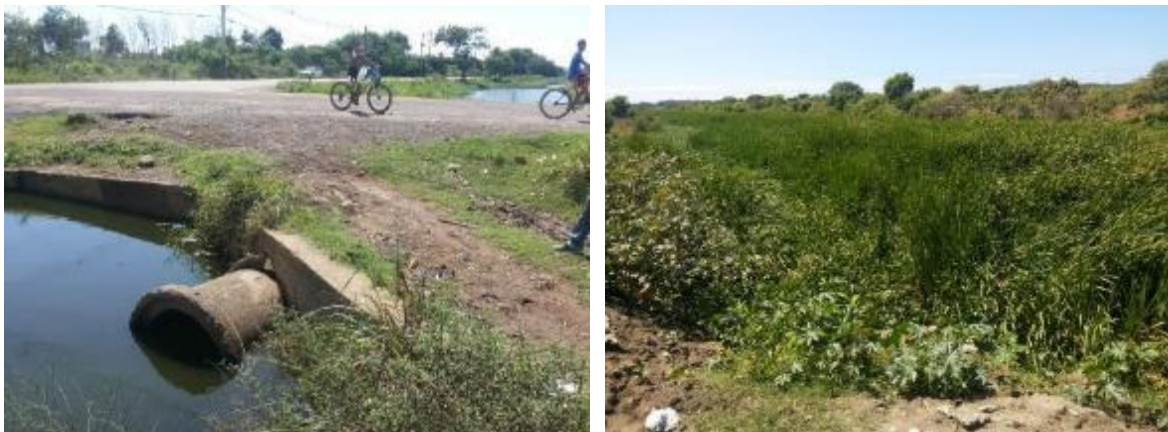
Figura 4: Travessia que restringe o canal Secundário (à esquerda) e vegetação posicionada ao longo do canal do Dique (à direita).
