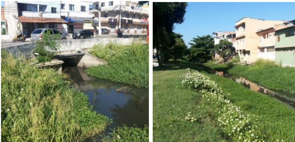
Figura 3: Ponte restringindo o escoamento (à esquerda) e vegetação ciliar e habitações dividindo espaço nas margens do canal (à direita).
