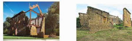
Ruína de Queimados - ES
