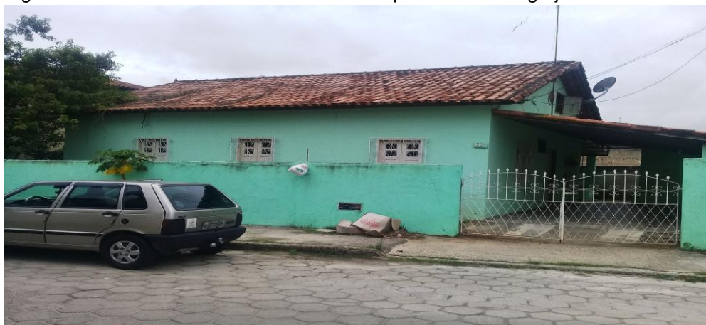
Figura 24 – A casa onde funcionou a creche após a saída da igreja.
