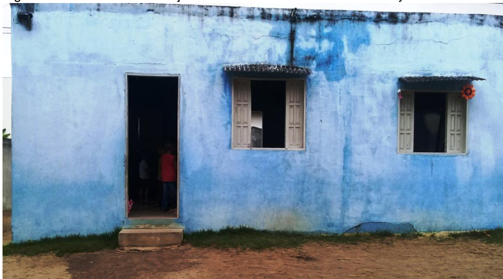
Figura 28 – Sede da Associação de Moradores do bairro Sernamby.
