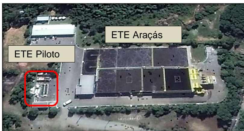
Figura 7- Foto aérea da Estação de tratamento de Esgoto de Araçás
