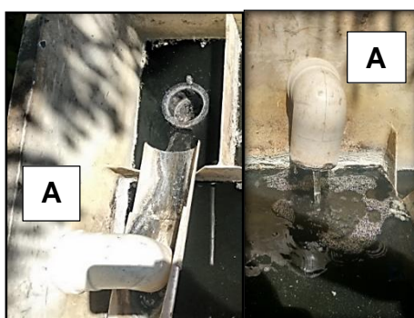
Figura 12- A) Ponto de amostragem e medição de vazão do efluente do RAC
