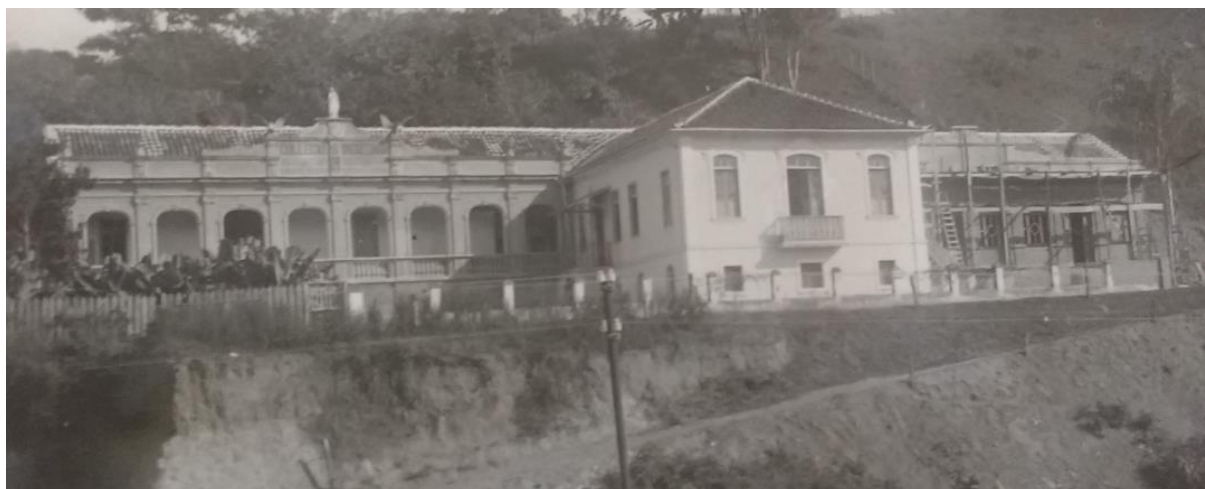
Figura 29 – Colégio Santa Teresinha, construção do Salão Nobre, c. 1931
