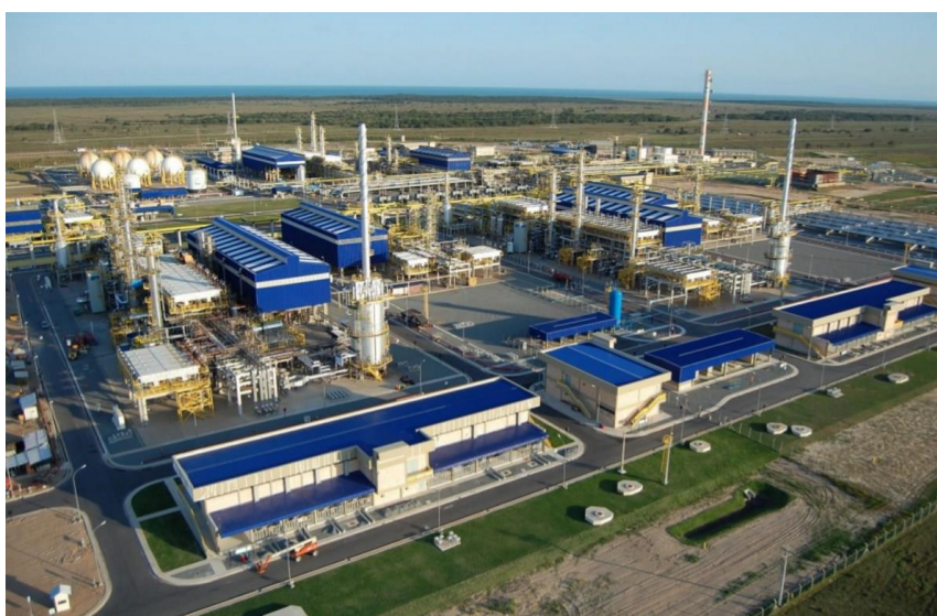
Figura 2 - Unidade de Tratamento de Gás de Cacimbas (UTGC) - Linhares-ES
