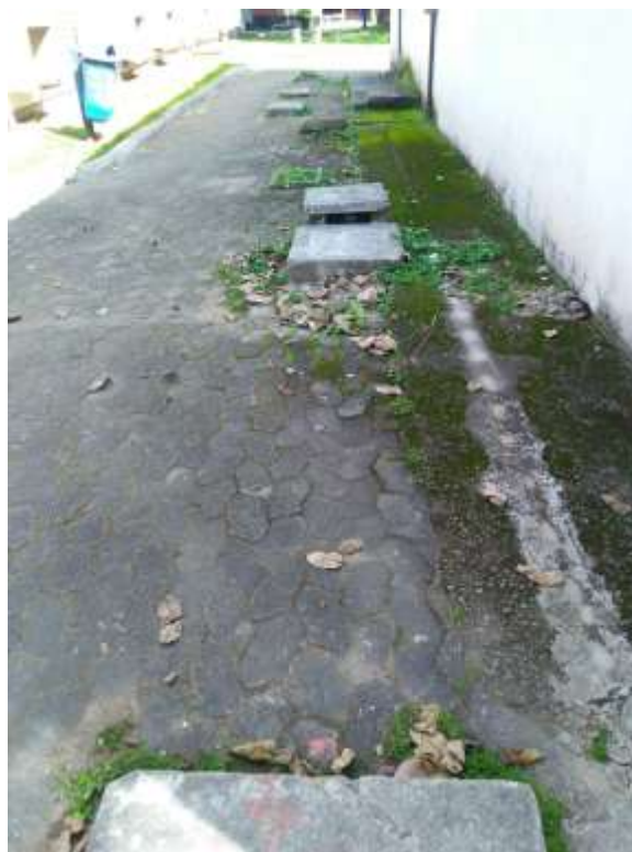
Figura 45 - Caixas de gordura no CCJE
