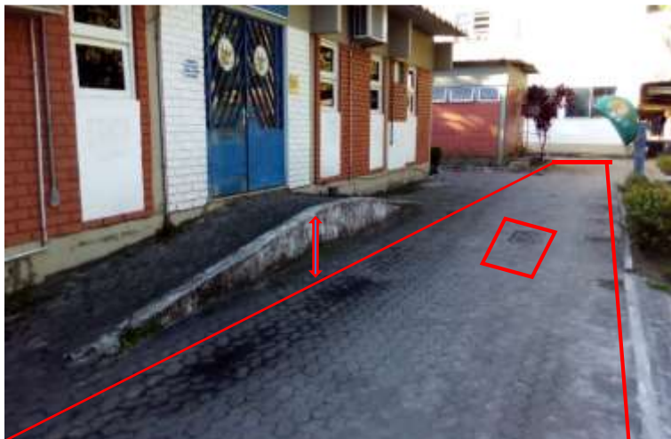
Figura 2 - Área de acesso
