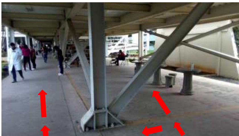
Figura 6 – Térreo do prédio de salas de aula do CCE
