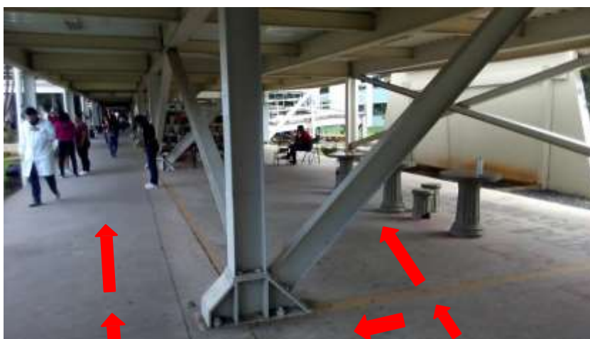
Figura 15 - Térreo do prédio de salas de aula do CCE
