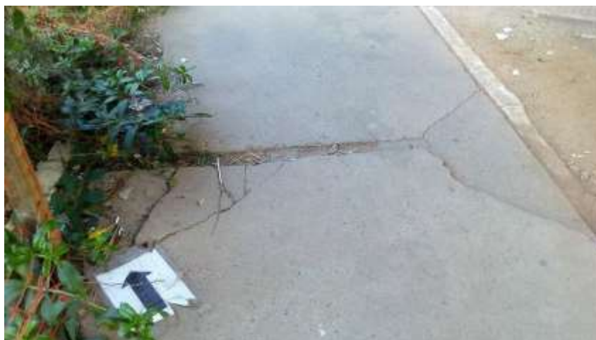
Figura 51 - Acesso à Biblioteca Central
