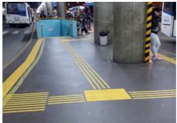
Figuras 16-B – Piso direcional para evitar pilastras
