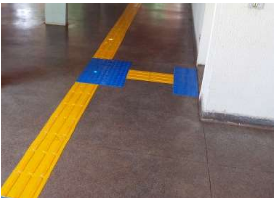
Figuras 16-A – Piso direcional para evitar obstáculos
