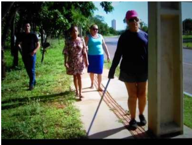
Figura 28 - Poste em local inadequado
