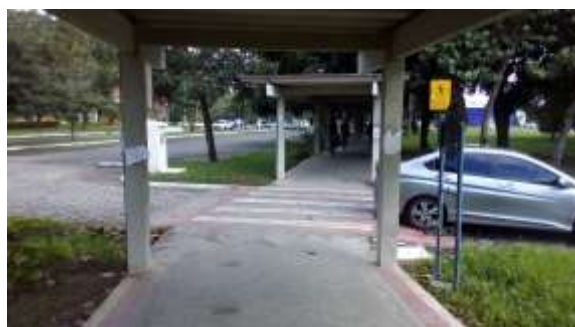
Figura 3 – Pista de acesso ao prédio da reitoria
