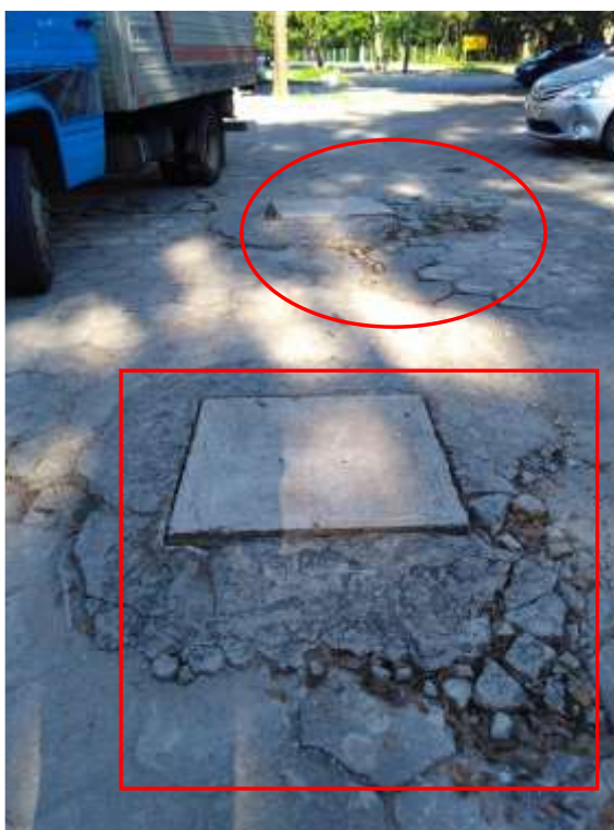
Figura 37 - Caixas de cimento no estacionamento
