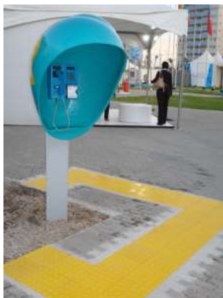
Figura 20 A – Orelhão devidamente sinalizado
