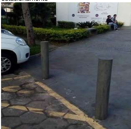
Figura 21 – Colunas de cimento no estacionamento
