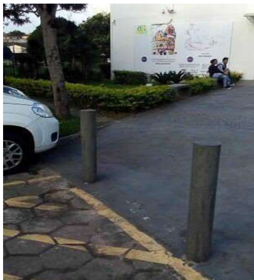
Figura 62 - Colunas de cimento no estacionamento
