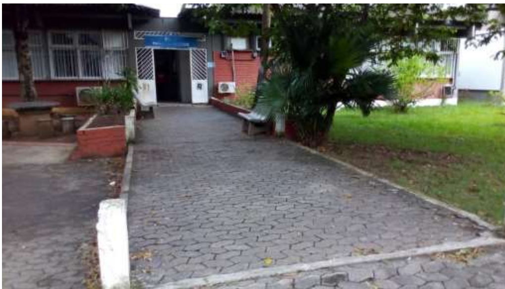
Figura 39 - Entrada de edificação CCJE
