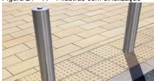
Figura 21 – A – Pilastras com sinalização
