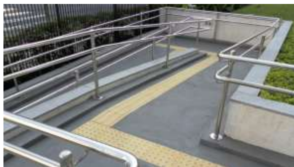
Figura 15-B – Rampa em curva
