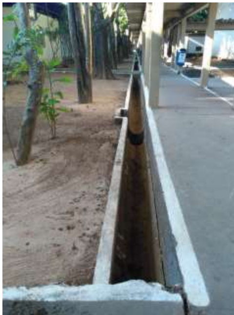
Figura 34 - Canaleta na passarela do CT
