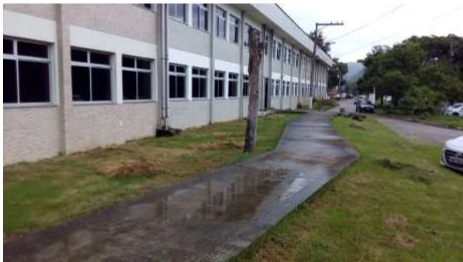
Figura 38 - Calçada cidadã no CCJE
