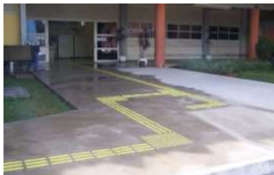
Figura 7-A – Sinalização para desvios de percurso
