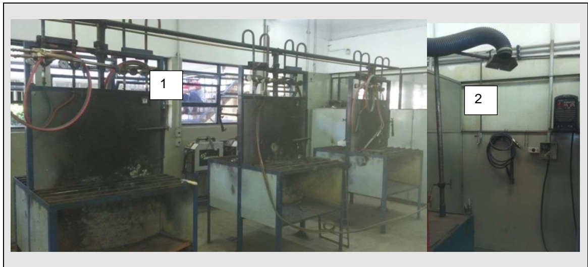
Figura 5 – Oficina de Soldagem do Senai-Vitória (CETEC-AF)
