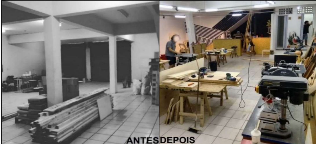
Fotografia 4 – Antes e após as adequações feitas pela empresa
