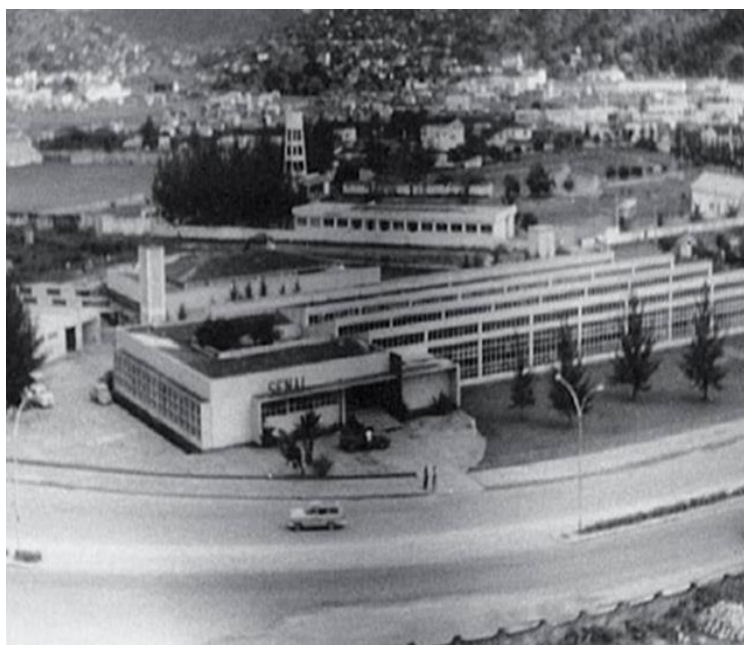
Figura 19: Vista externa do Centro de Formação Profissional Jerônimo Monteiro, primeira escola em sede própria, em 1964.
