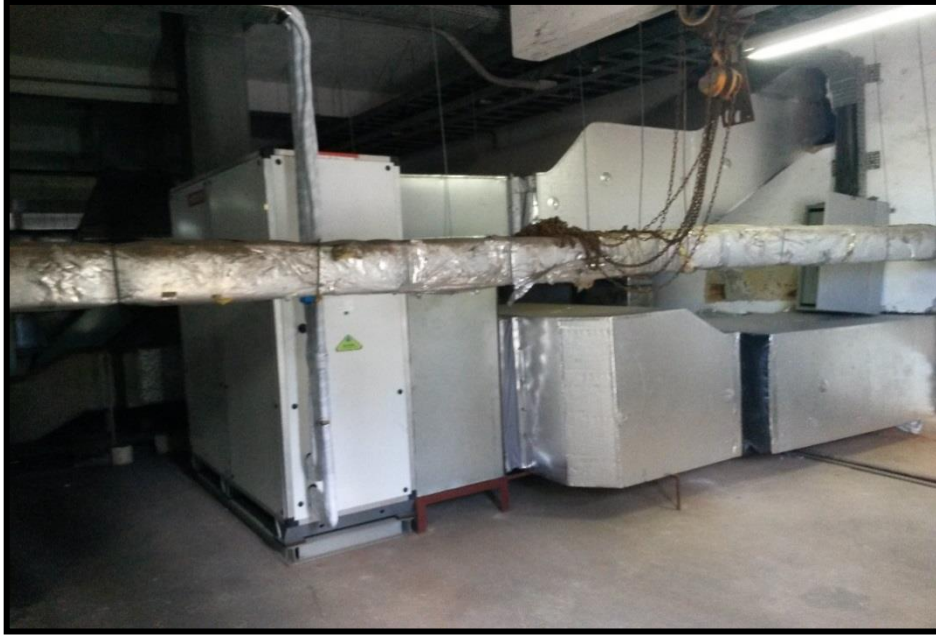
Figura 9 – Unidade Evaporadora Fonte: Gerência de Infraestrutura da Vale S.A., (2018).
