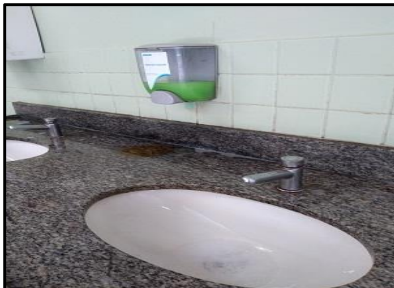
Figura 21 – Torneira de acionamento automático simples Fonte: Elaborado pelo autor (2018).
