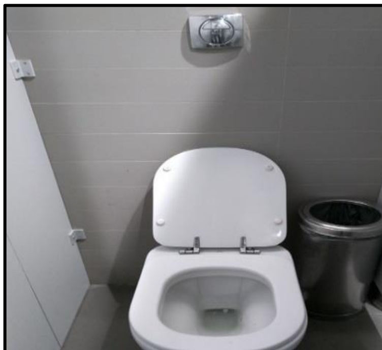
Figura 23 – Válvula de descarga com duplo acionamento Fonte: Elaborado pelo autor (2018).
