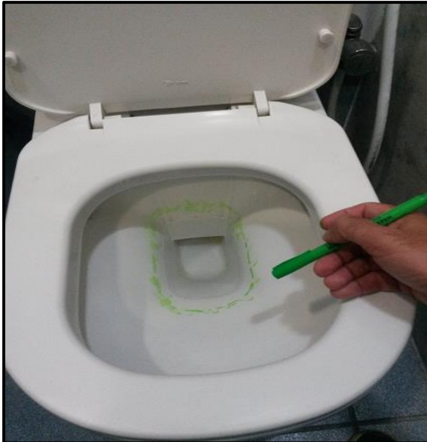
Figura 14 – Teste de vazamento em bacias sanitárias Fonte: Elaborado pelo autor (2018).
