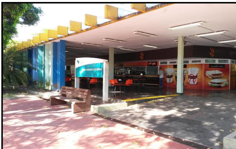
Figura 4 – Vista frontal do Restaurante Central da Vale Fonte: Elaborado pelo autor (2018).
