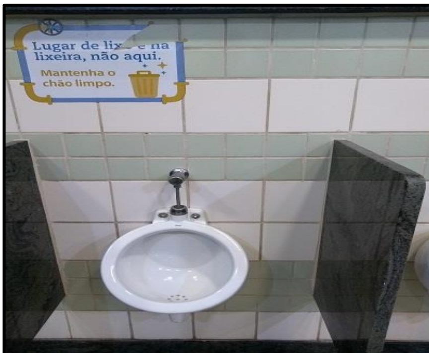
Figura 22 – Mictório com acionamento automático simples Fonte: Elaborado pelo autor (2018).
