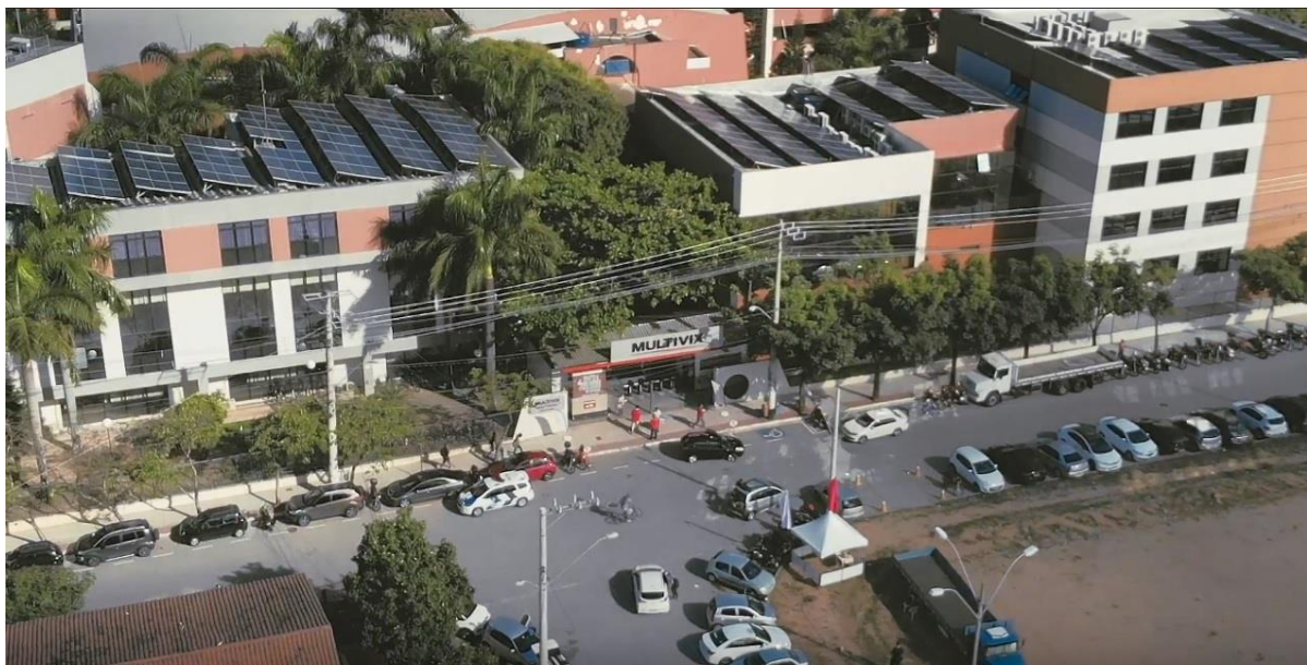
Figura 8 – Sistema de GD solar fotovoltaico instalado no telhado da UC 03 (a) e sala dos inversores e das proteções do sistema (b)
