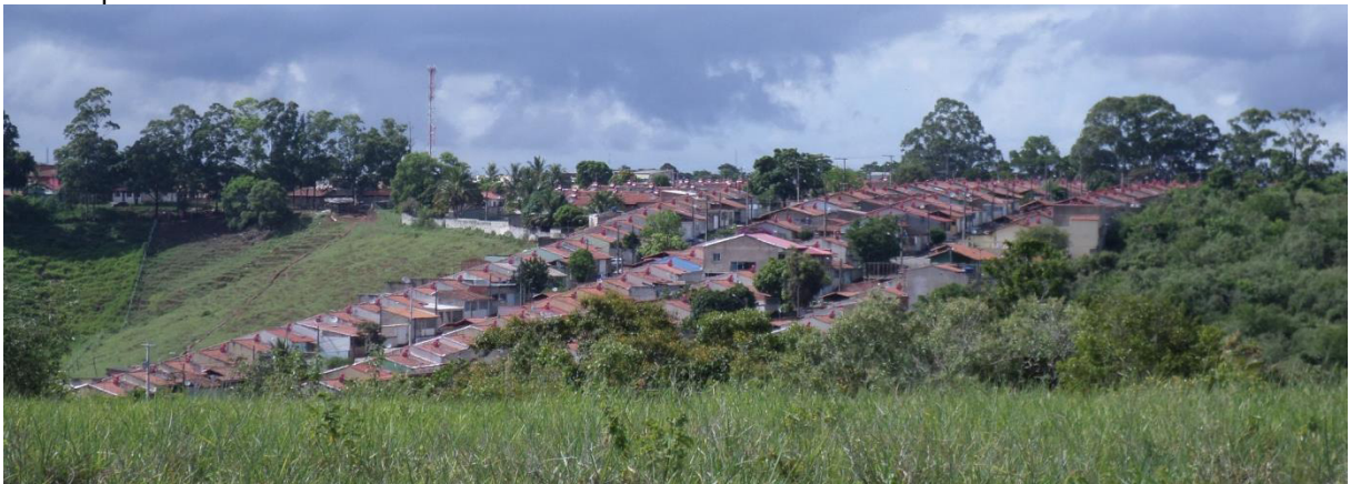
Figura 101: Área de Risco de Escorregamento no bairro de Cidade Pomar no Sistema Fluvial do Rio Jacaraípe.
