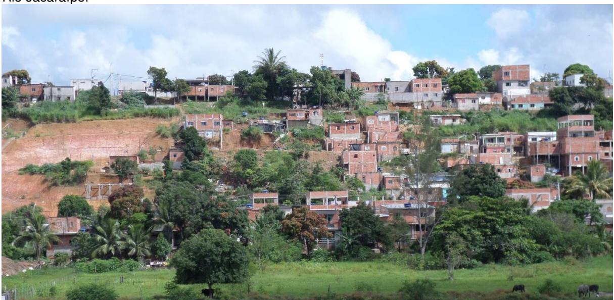
Figura 102: Área de Risco de Escorregamento no bairro de Planalto Serrano no Sistema Fluvial do Rio Jacaraípe.
