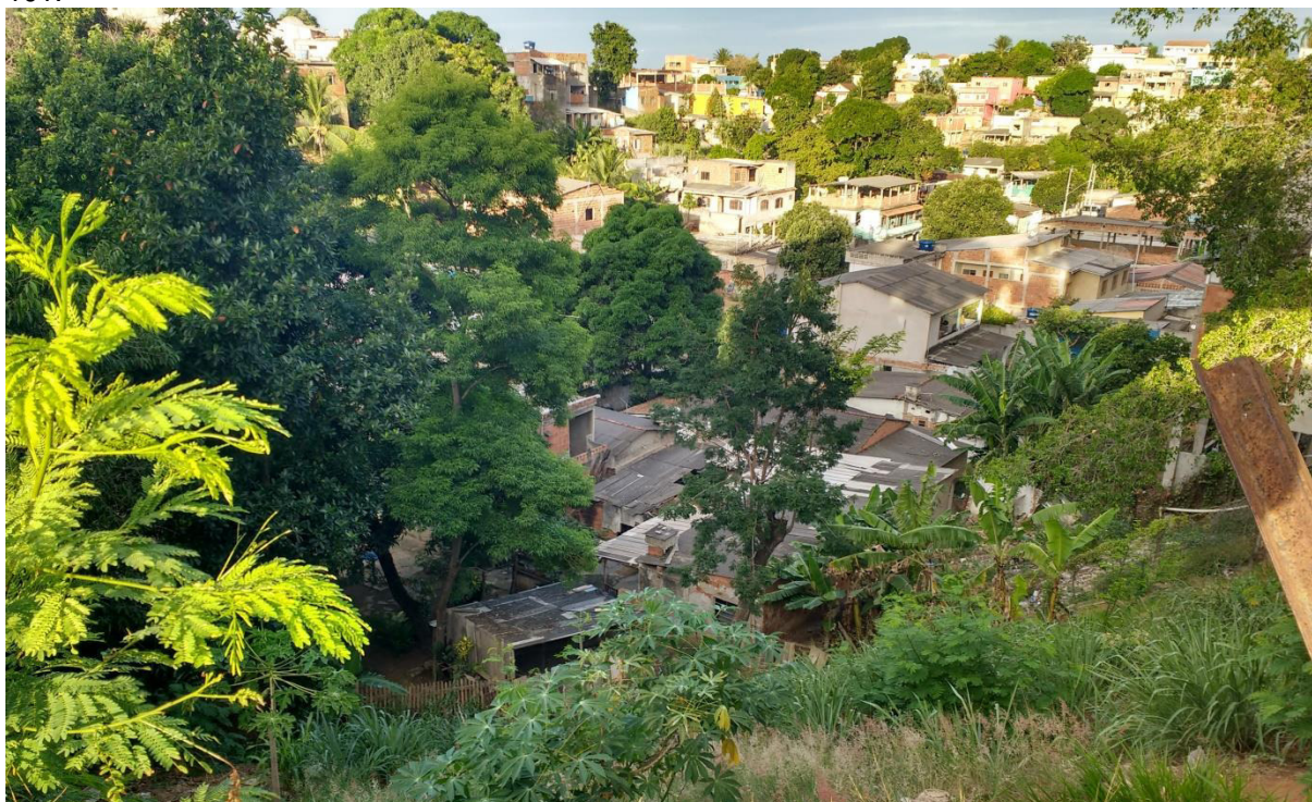
Figura 68: Ocupação de Vertentes e Fundos de Vale, no bairro Nova Carapina I, as margens da BR 101.
