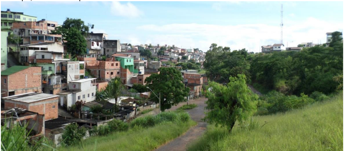
Figura 61: Tipologia 1 de Ocupação de Vertentes e Fundo de Vale no Sistema Fluvial do Rio Jacaraípe, no bairro Taquara II.
