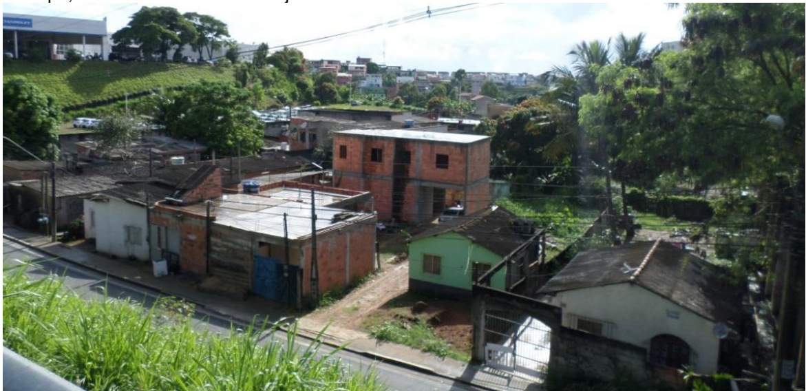
Figura 62: Tipologia 1 de Ocupação de Vertentes e Fundo de Vale no Sistema Fluvial do Rio Jacaraípe, no bairro Colina de Laranjeiras.
