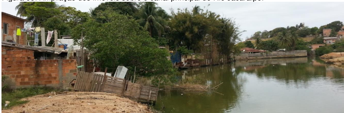
Figura 53: Ampliação dos imóveis sobre o canal principal do Rio Jacaraípe.
