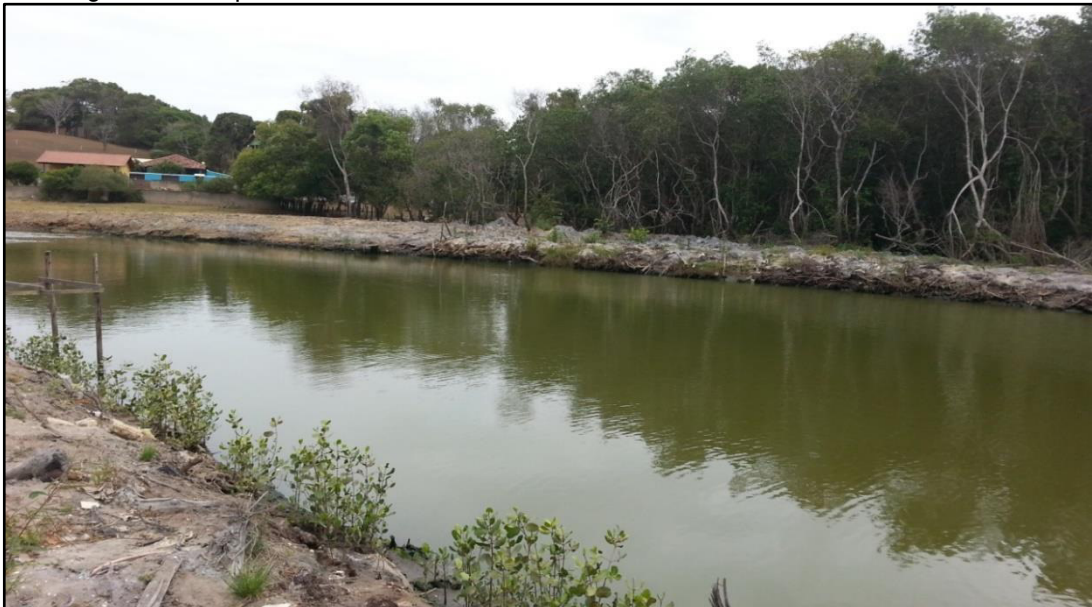
Figura 09: Exemplo de remoção de ambas as margens do Rio Jacaraípe, Serra/Espírito Santo para obra de alargamento e aprofundamento da calha.
