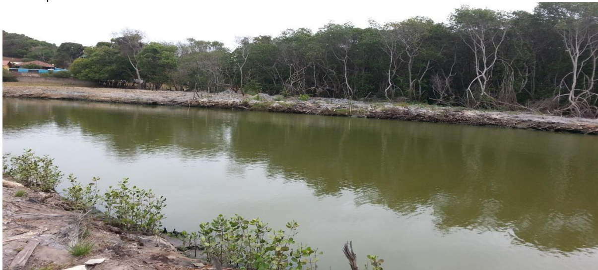
Figura 59: Supressão de vegetação de mangue da margem direita do canal principal do Rio Jacaraípe.
