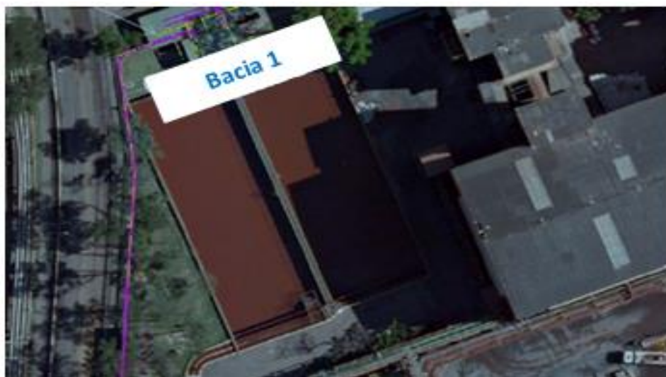
Figura 14 - Localização da bacia de decantação 1 da Unidade de Tubarão
