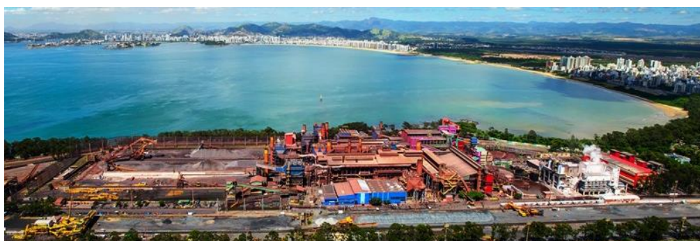
Figura 6 - Vista panorâmica do Unidade de Tubarão – Vitória ES
