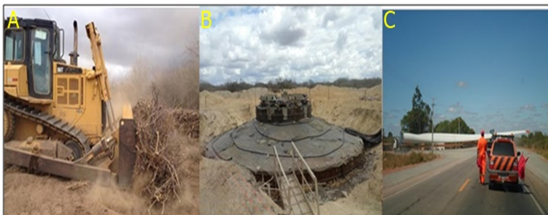
Figura 16 - Etapas da construção de aerogeradores
