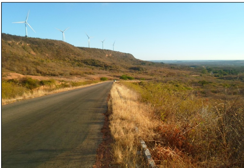
Figura 11 - Aero geradores instalados em borda de chapada em Marcolândia/PI
