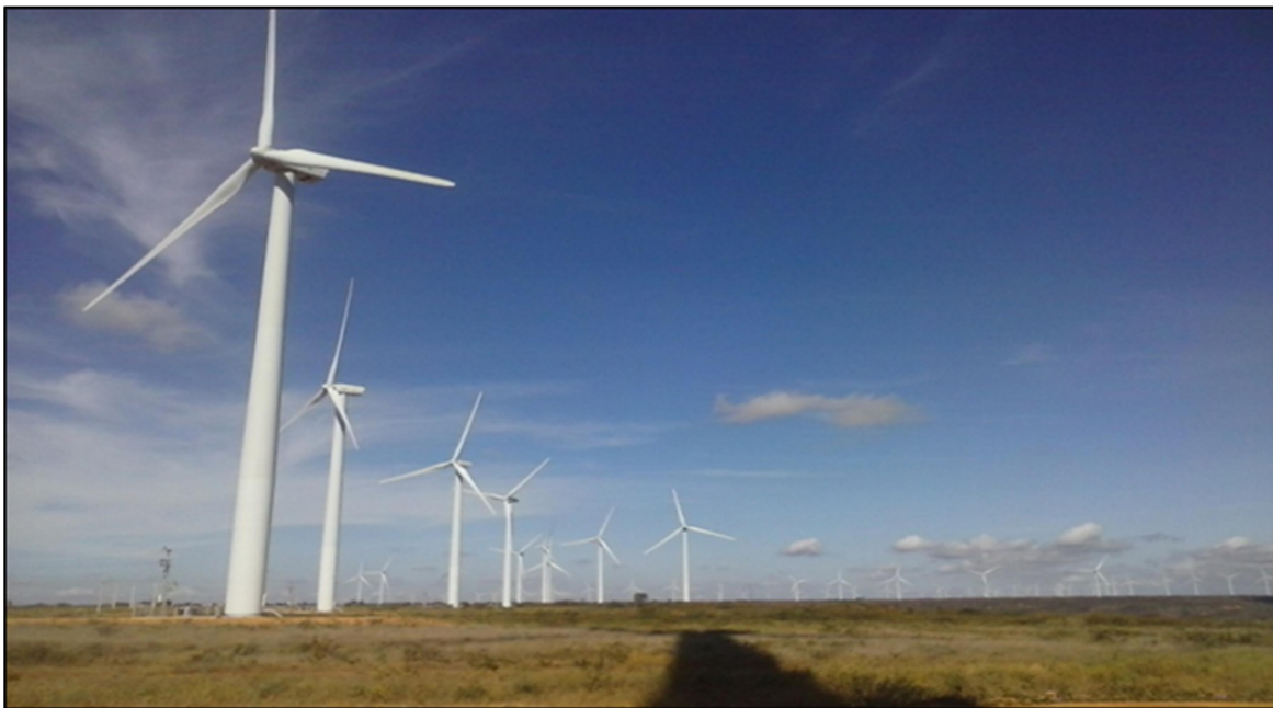
Figura 9 - Vista do parque localizado na comunidade Serra do Cícero Mundinho, município de Marcolândia/PI.
