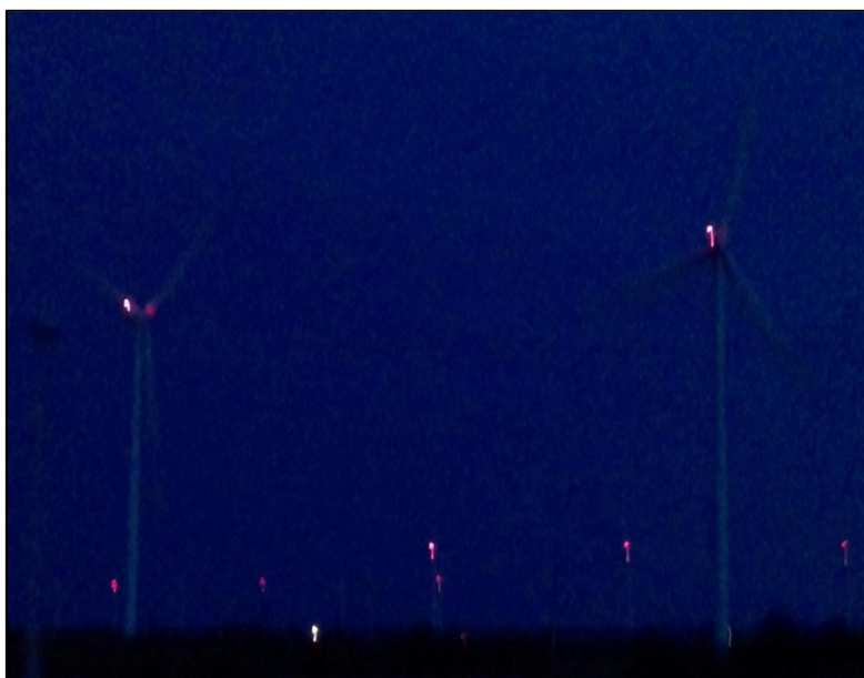
Figura 24- Pequenas luzes vermelhas nas torres eólicas, Município de Marcolândia/PI.
