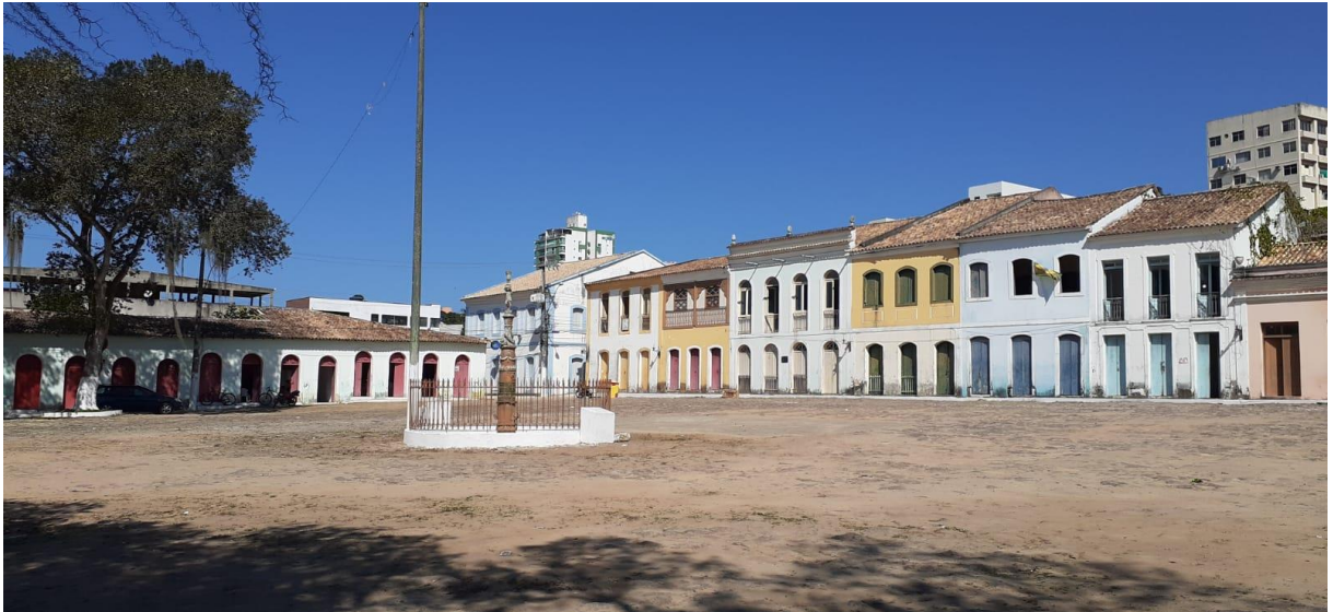
Vista do Largo do Chafariz, com o conjunto de imóveis tombados, construídos na sua maioria no século XIX, décadas de 1840 e de 1850. Foto do autor, 17 de setembro de 2021.
