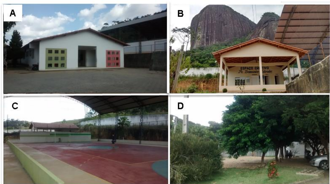
Figura 7 - Estrutura Física da EMEF “Pedra Torta”
